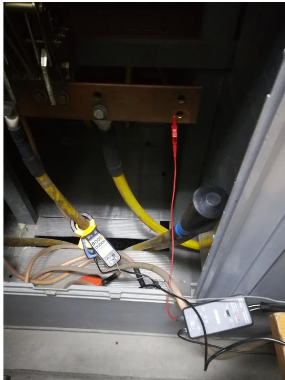
Figura 3.6: Disposizione degli strumenti di misura in cabina stadio
