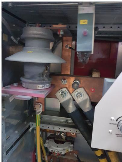
Figura 4.1: Esempio di scaricatore scoppiato in cabina
