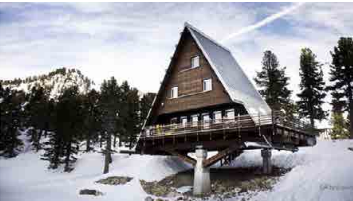
2.Casa Capriata (1954) di Carlo Mollino sopra Gressoney. Il progetto realizzato nel 2011
