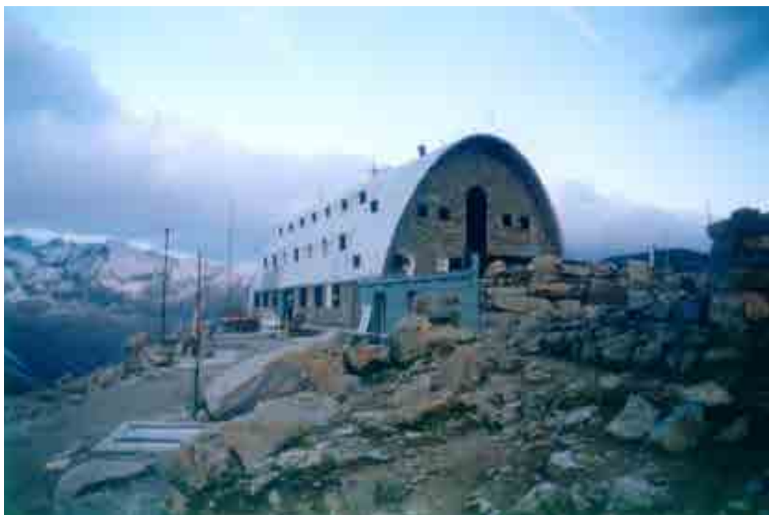
64. 2001. Vista dal rifugio Vittorio Emanuele II e l'ampliamento effettuato sulla parte anteriore (autore non identificato), documento di G.Studio Enrico Giacopelli.
