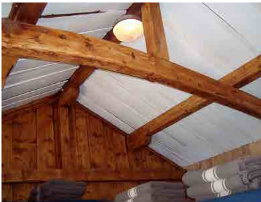
83. Vista del interno del rifugio vecchio utilizzata come locale invernale ristrutturata recentemente, foto è stata scattata da me.
