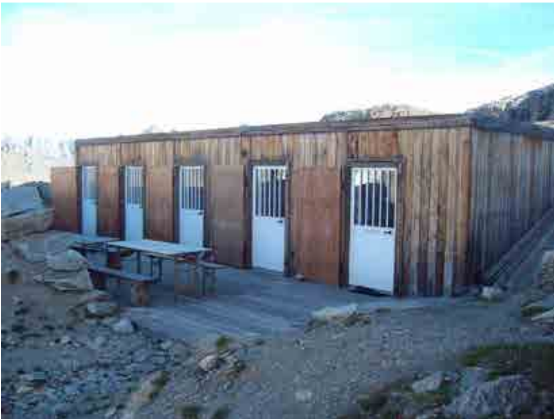
68. Container adibiti a dormitori, la foto è stata scattata da me.
