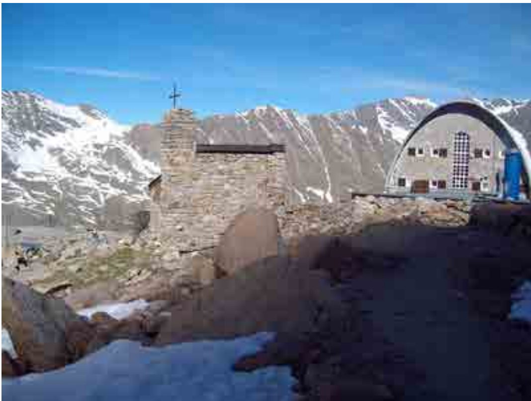
72. da sinistra, Cappella costruita intorno all'anno di inaugurazione (1961), attualmente adibito a magazzino, il Nuovo rifugio Vittorio Emanuele II e camino della centrale termica dell'ampliamento del 2004, la foto è stata scattata da me.
