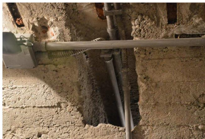
Foto n. 6 - Passaggio delle canaline, r.p.a. presso il Museo della Resistenza, Torino.
