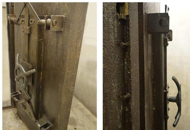
Foto n. 4 - Porte a tenuta stagna tipicamente adottate, r.p.a. sottostante Palazzo Civico, Torino.
