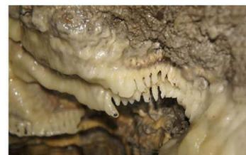
Foto n. 6 - Alcune gallerie presentano un'elevata forma di degrado dovuta alla reazione di dissoluzione carsica, r.p.a. "Kleine Berlin", Trieste.
