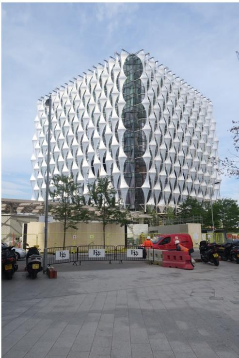
Fig.139, Rivestimento ETFE facciate sud e ovest, luglio 2017
