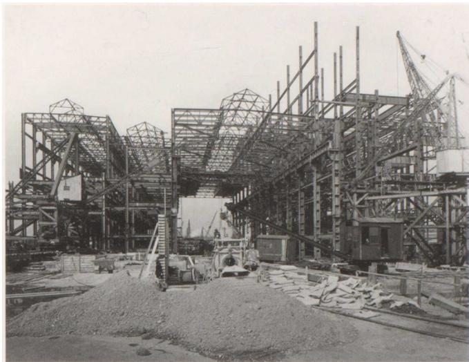
*Fig.62, Battersea Power Station, struttura portante Stazione "A" ad opera di Sir William Arrol & Co. Ltd, 1931*
