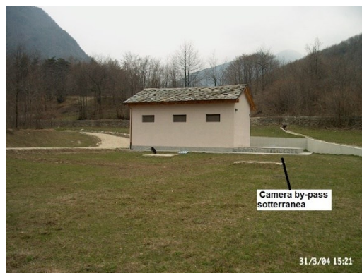
Figura 2.6: Foto del locale della minicentrale di Balma di Roure, concessione di API S.p.a.
