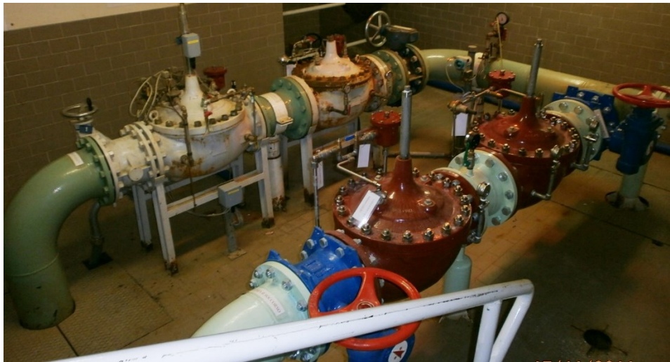
Figura 2.14: Foto del by-pass della minicentrale di Inverso Pinasca, concessione di API S.p.a.
