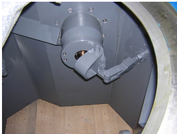
Figura 2.9: Foto del tegolo deviatore della spina distributrice della turbina Pelton di Balma di Roure, concessione di API S.p.a.
