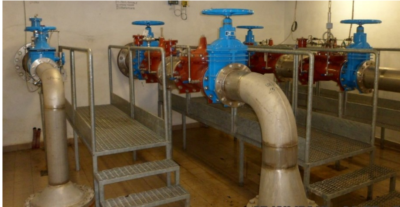
Figura 2.10: Foto del by-pass della minicentrale di Inverso Pinasca, concessione di API S.p.a.
