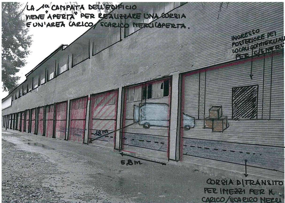
Figura 4.55 – Prospetto secondario del fabbricato A, campata adibita ad area carico-scarico merci coperta
