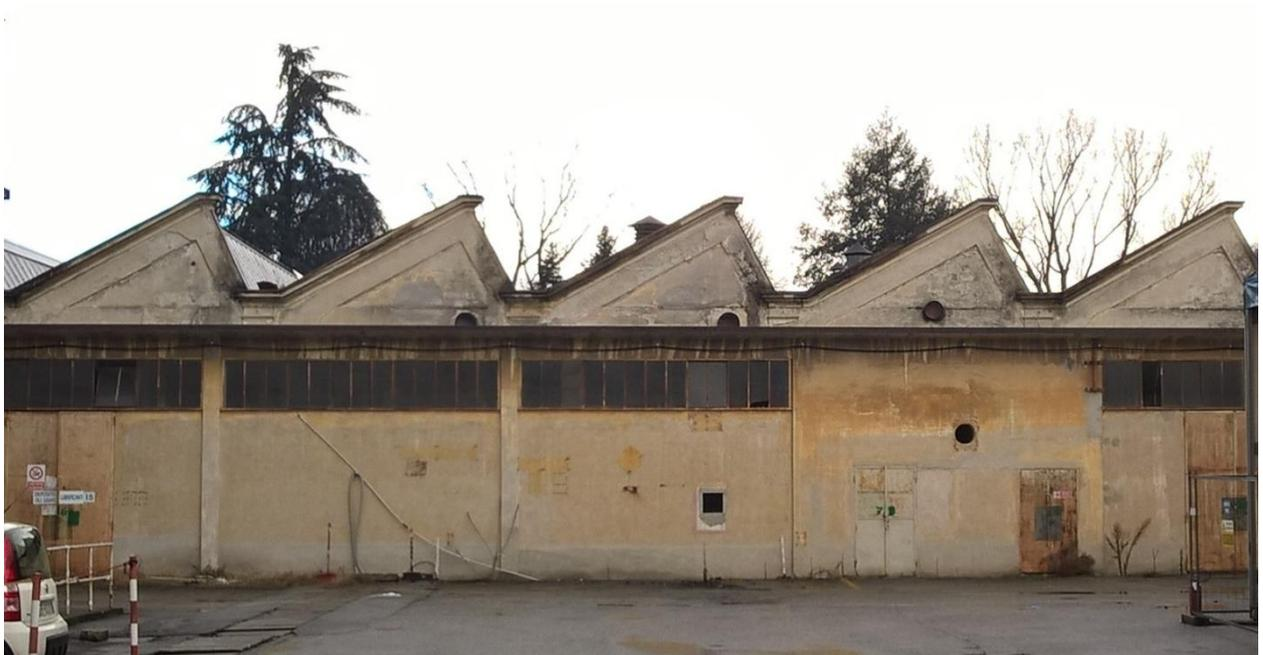
Figura 4.18 - Edificio Re<sub>1</sub> – particolare copertura a shed, tipica dell'architettura industriale
