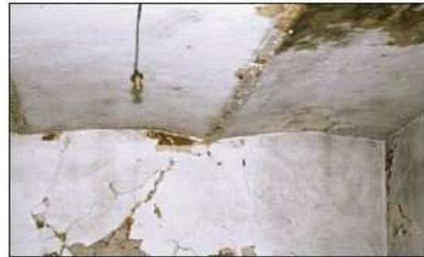
Solaio con travi di ferro a voltine.
