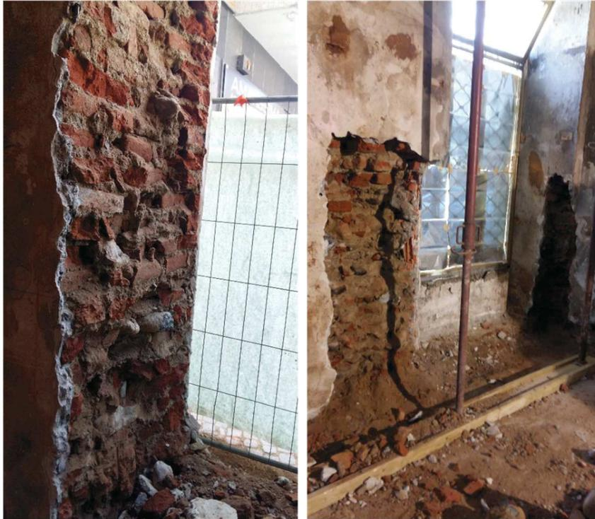
*Figura 64 - Muratura portante in mattoni di un edificio del centro storico, Settimo Torinese*
