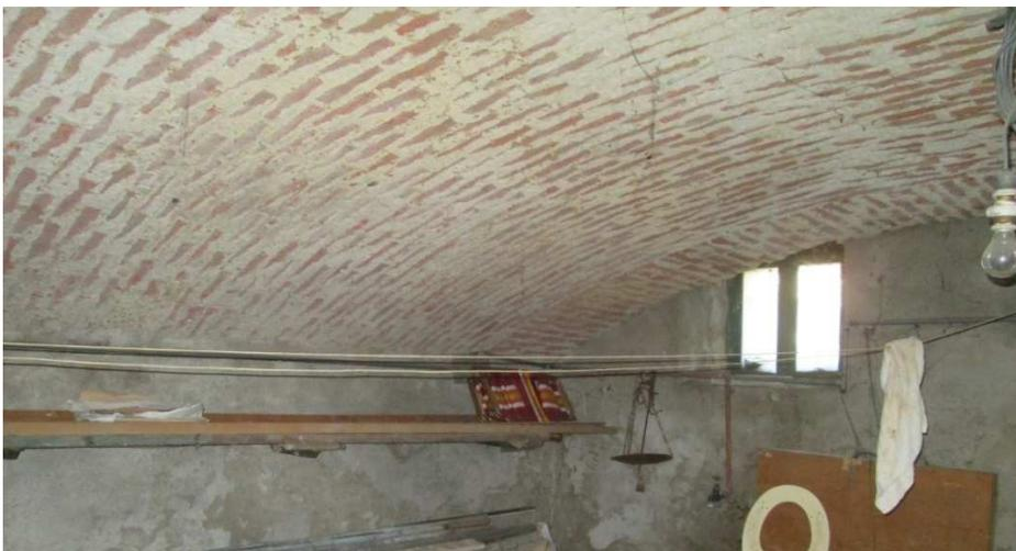
*Figura 65 - Volta a botte in mattoni di un edificio nei pressi del centro storico, Settimo Torinese*
