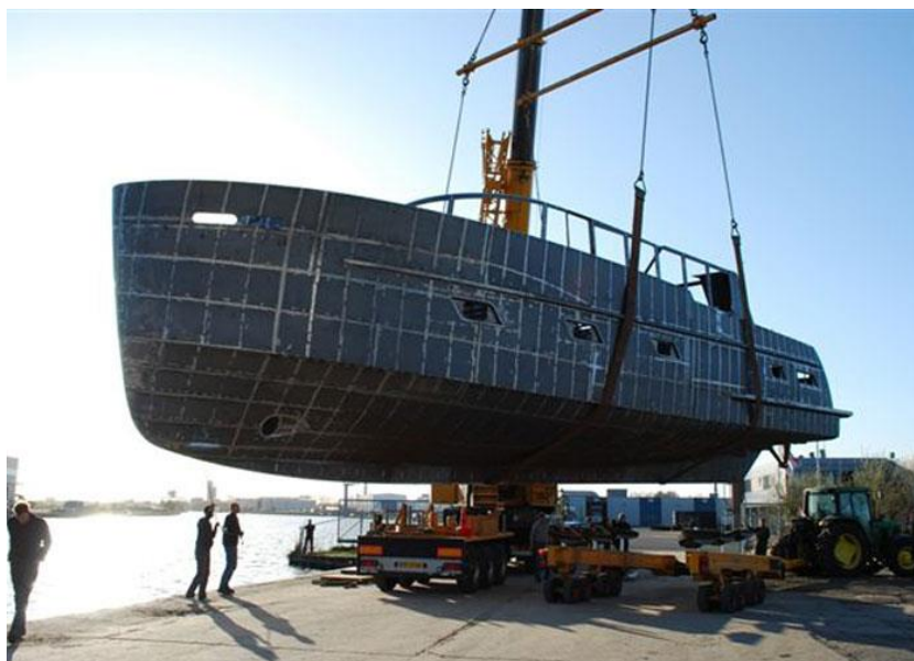
Fig. 2.2.4.1 Scafo in acciaio
