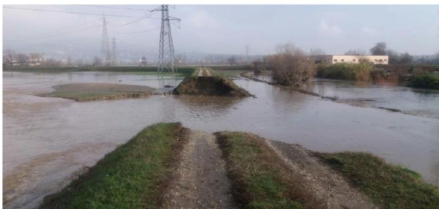
Figura 6, rotta arginale a valle del ponte di strada Barauda. Vista da valle verso monte. Fonte AiPo.
