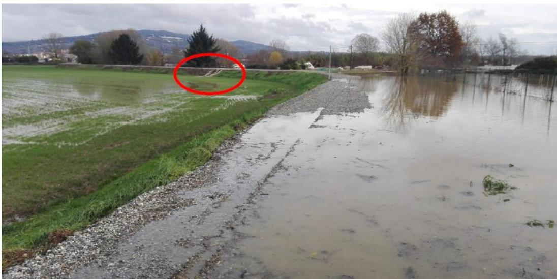
**Figura 5, vista da monte verso valle dell'argine sinistro del T.Chisola. Raggiungimento della sommità e inizio della tracimazione (25/11/16 h 11:00). Fonte AiPo.**
