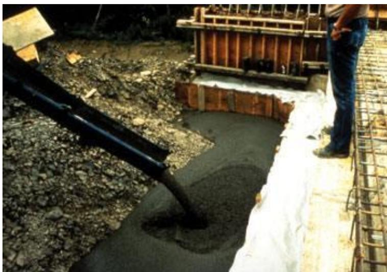
**Figura 2.1** - riempimento spalle da ponte con clsm.
