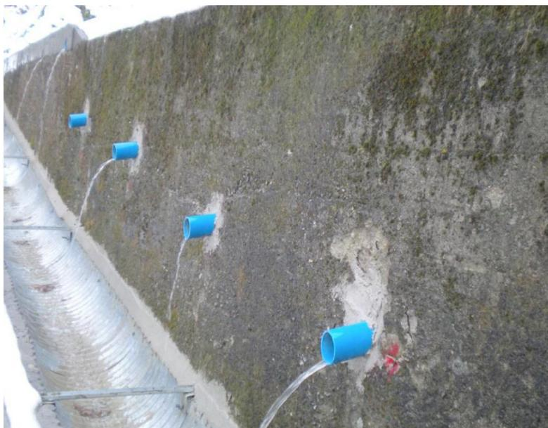
Figura 114. Esempio sbocco di tubi drenanti da un'opera di sostegno ([www.agperforazioniescavi.it](http://www.agperforazioniescavi.it))
