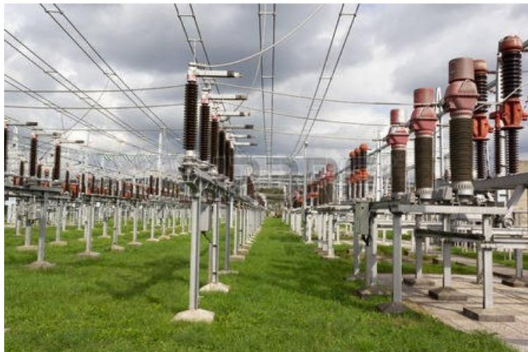
**Figura 2.8** Stazione elettrica con isolamento in aria.
