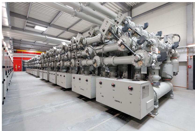
**Figura 2.9** Stazione elettrica con isolamento in SF6.
