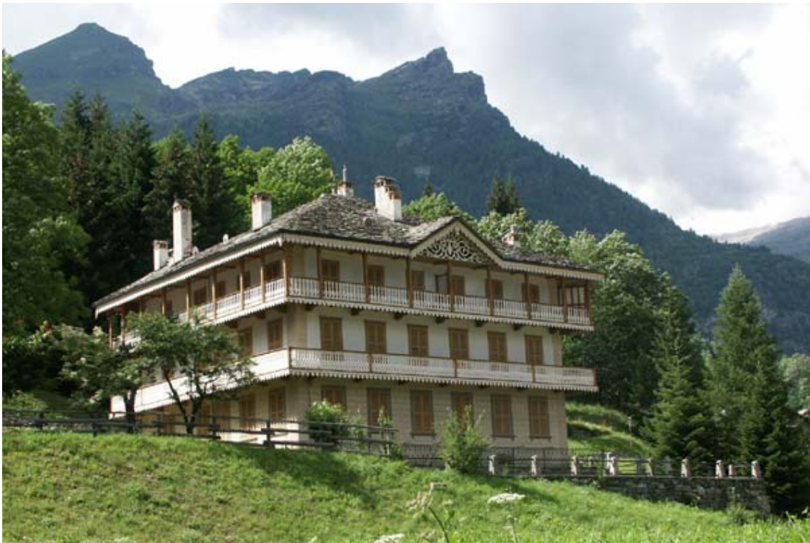
Villa Grober ad Alagna, progettata da Cristoforo Grober
