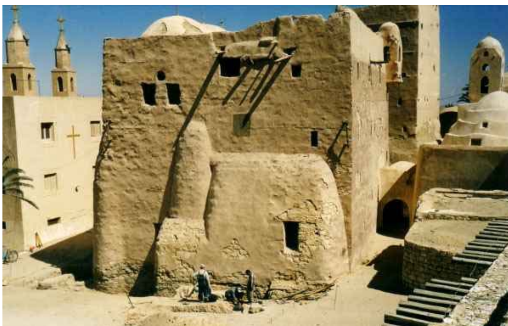
La rubbatya prima dei lavori di consolidamento
