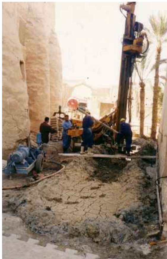
L'intervento di consolidamento tramite i pali-radice
