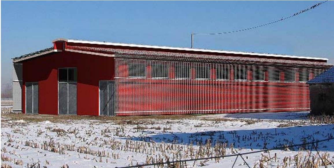
Progetto del nuovo involucro per la stalla con soluzione a pannelli grigliati
