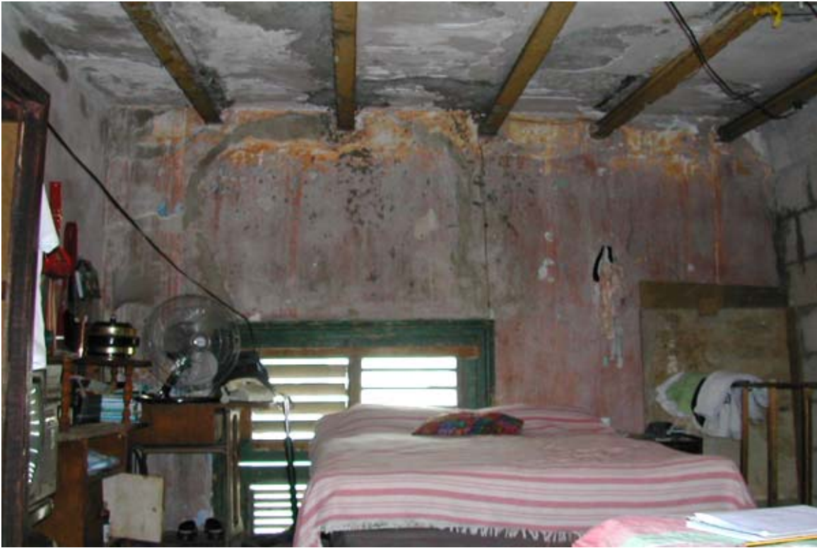
Parte interna del edificio (foto E. Castaldi)
