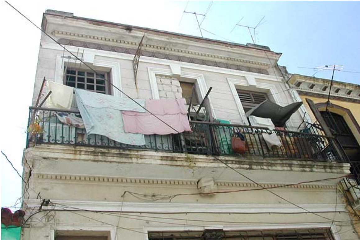
Parte externa del edificio (foto E. Castaldi)
