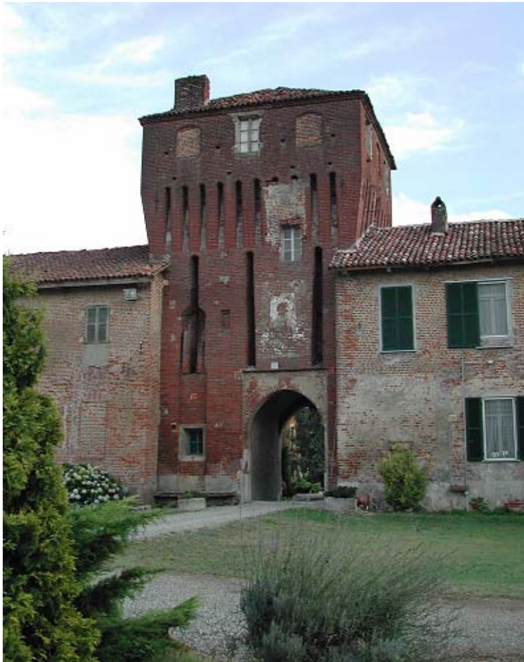
Vista della torre, fronte nord
