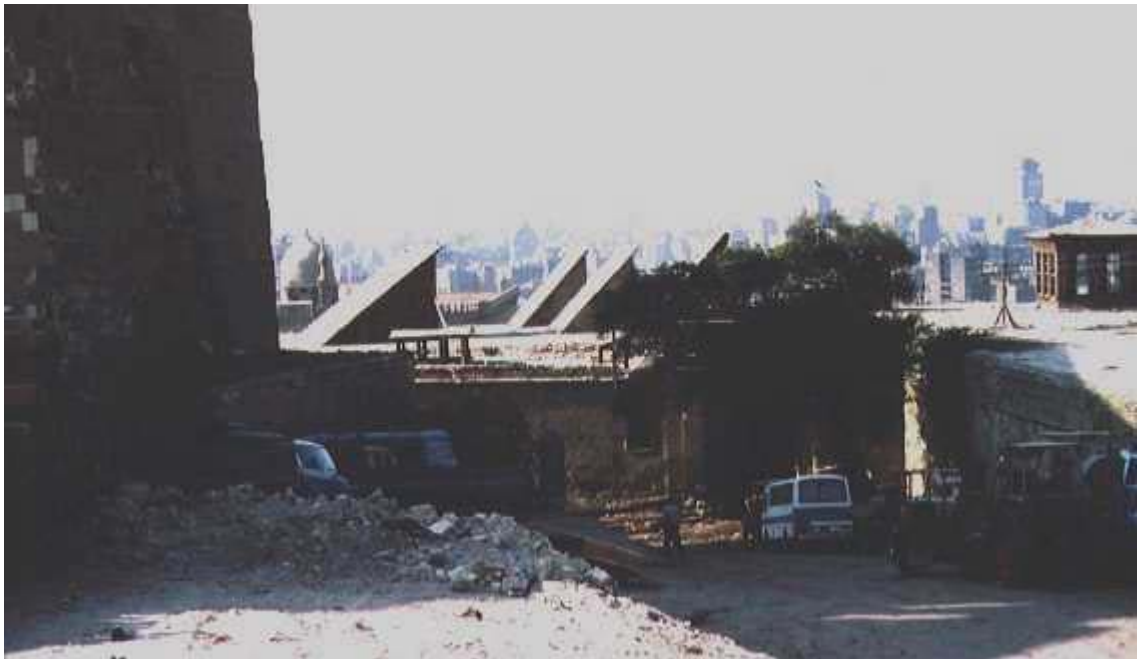
Fig.1 - Malqaf, ovvero torri del vento tradizionali, viste dalla Cittadella del Cairo. Il malqaf , con l'apertura rivolta a nord, è in grado di captare le brezze dominanti (in Egitto provenienti da quella direzione) e di evitare che la radiazione solare diretta penetri nei cortili o nei locali coperti da tali sistemi. Malquaf, or wind-tower, seen from Cairo Citadel.
