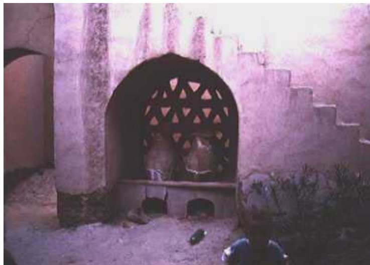
Fig. 3 - Resthouse, casa campione per i rilevamenti climatici, nel villaggio di New Gourna. L'edificio è realizzato attorno ad una corte centrale, fornita di vegetazione e di alcune giare contenenti acqua, poste entro un mazeer. Tutti questi accorgimenti cooperano per migliorare il microclima interno all'abitazione.
