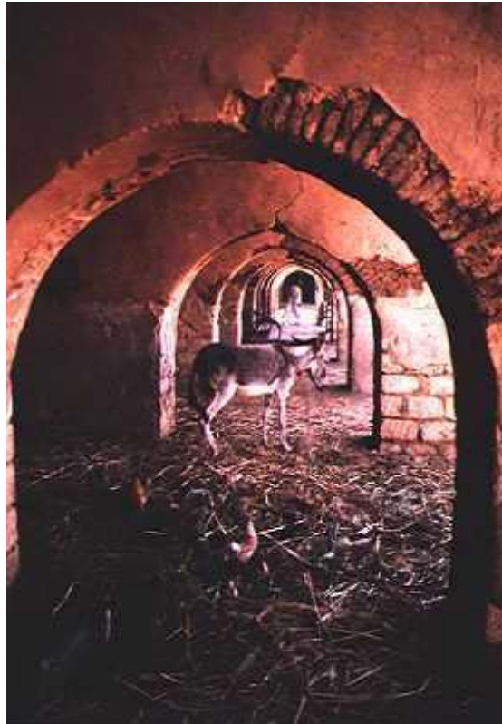
Fig. 2 - Villaggio di New Gourna, Luxor, Egitto. Parte coperta del mercato, realizzata con volte nubiane in mattoni di terra cruda. Il mercato oggi è abbandonato e viene utilizzato solo più come discarica o stalla per gli animali.
