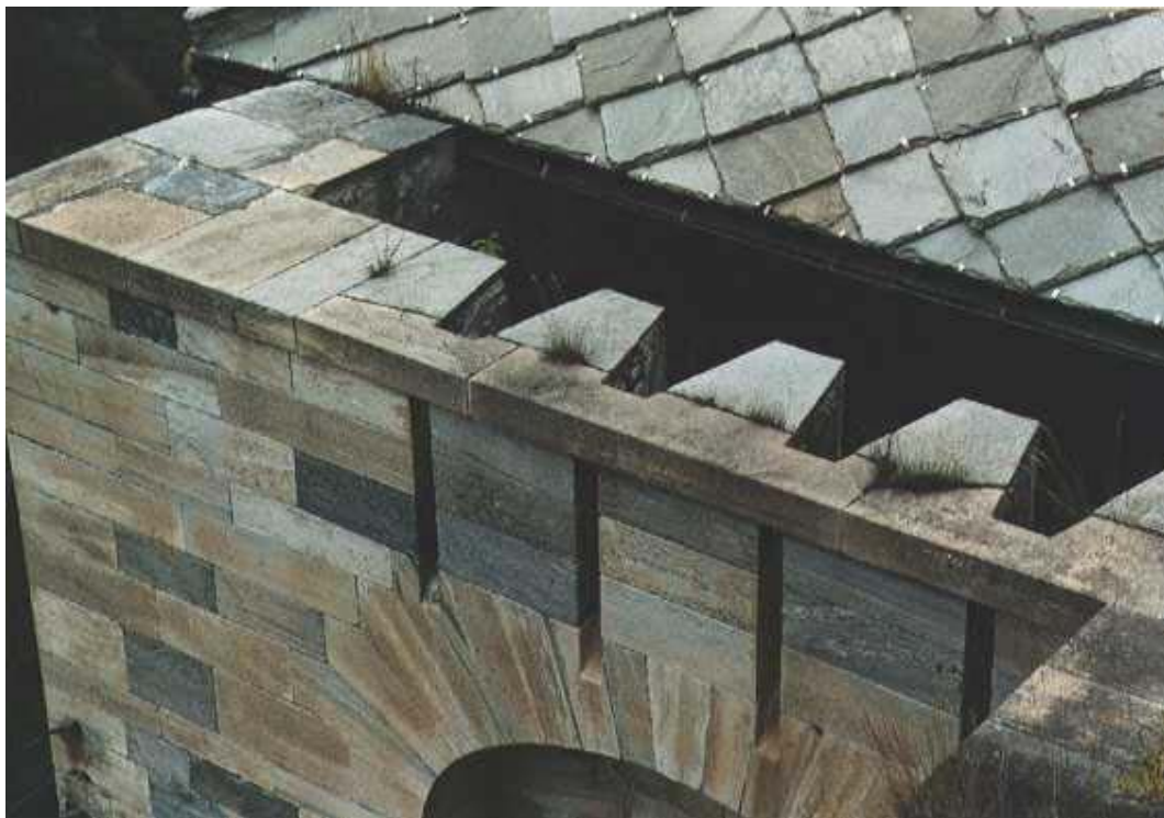
Figura 2: Il Forte di Exilles: analisi "tipologica" di cortine e aperture per bocche da fuoco.
