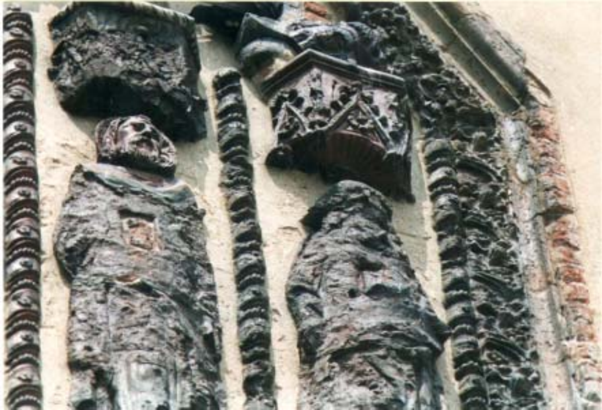
Duomo di Chivasso, particolare della ghimberga, dopo i lavori di consolidamento degli anni '70
