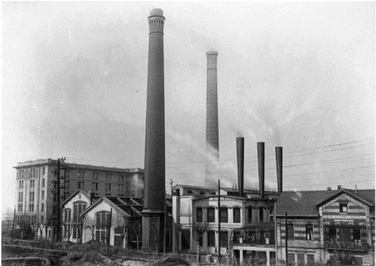
Torino - Centrale del Martinetto (1907 c.)
