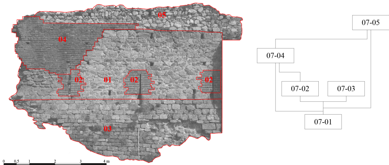
Fig.3 - Esempio di suddivisione in unità di una superficie muraria del castello e, sulla destra, matrix relativo tra queste
