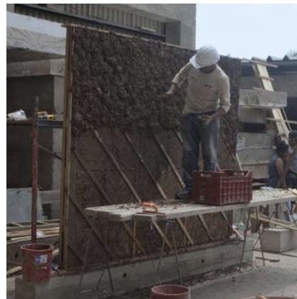
Prototipo in scala reale del sistema misto in legno e terra alleggerita durante la fase di sperimentazione costruttiva presso il Centro Tierra-PUCP.
