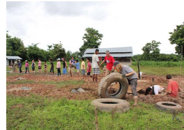
Figura 111. "Pneumatici utilizzati per le fondazioni".
