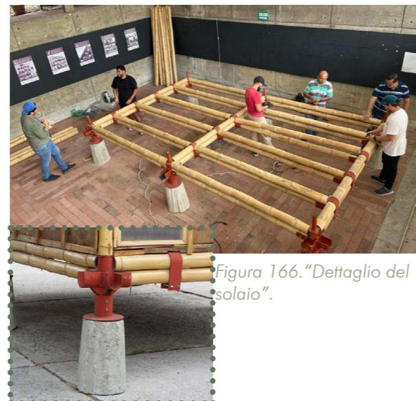
Figura 166. "Dettaglio del solaio".
