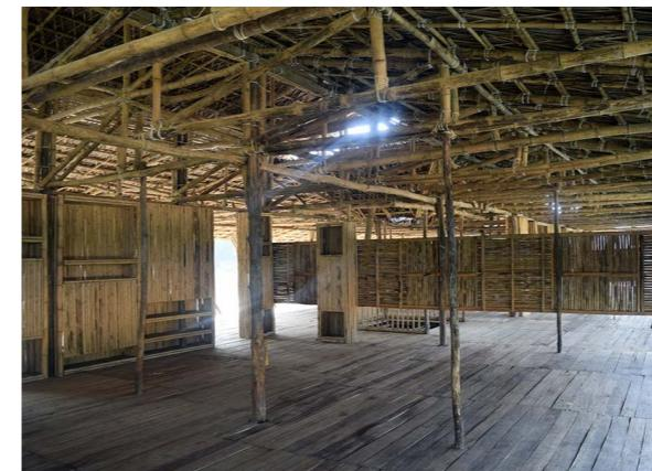
Figura 133. "Vista interna con dettaglio della copertura".
