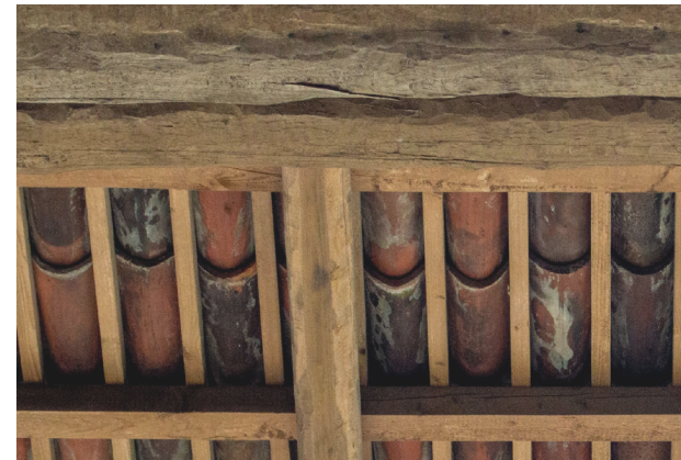
Uso di coppi di recupero in copertura Fonte immagine:autrice.
