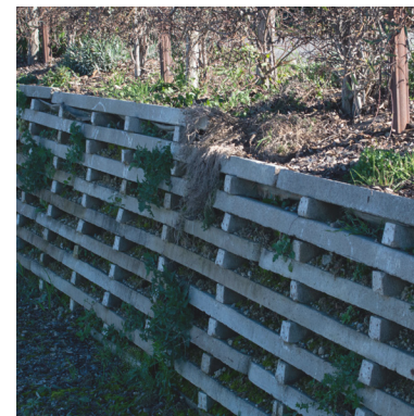
Terrazzamenti realizzati con pali di vite dismessi Fonte immagine:autrice.
