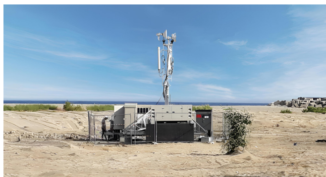
Sistema DAS portatile per Tourneè estiva Jovanotti. 3 Esempio di sistema DAS della società INWIT.
