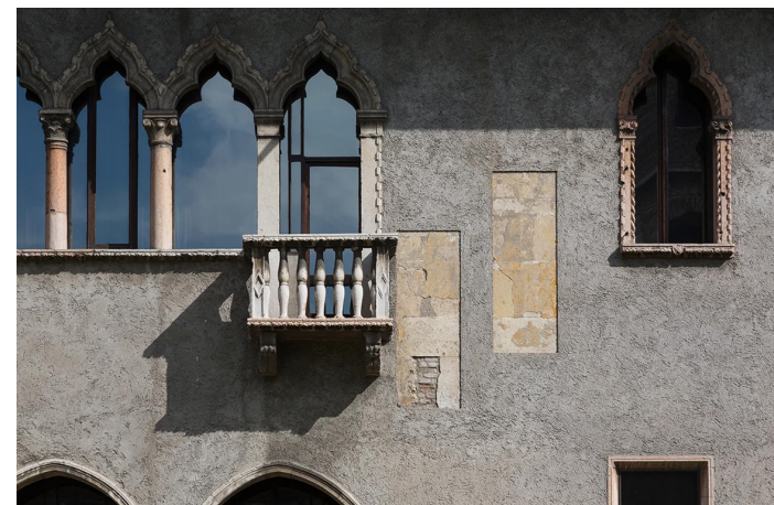
Dettaglio esterno che mostra le stratificazioni costruttive del Museo di Castelvecchio, Carlo Scarpa, 1958-1974
