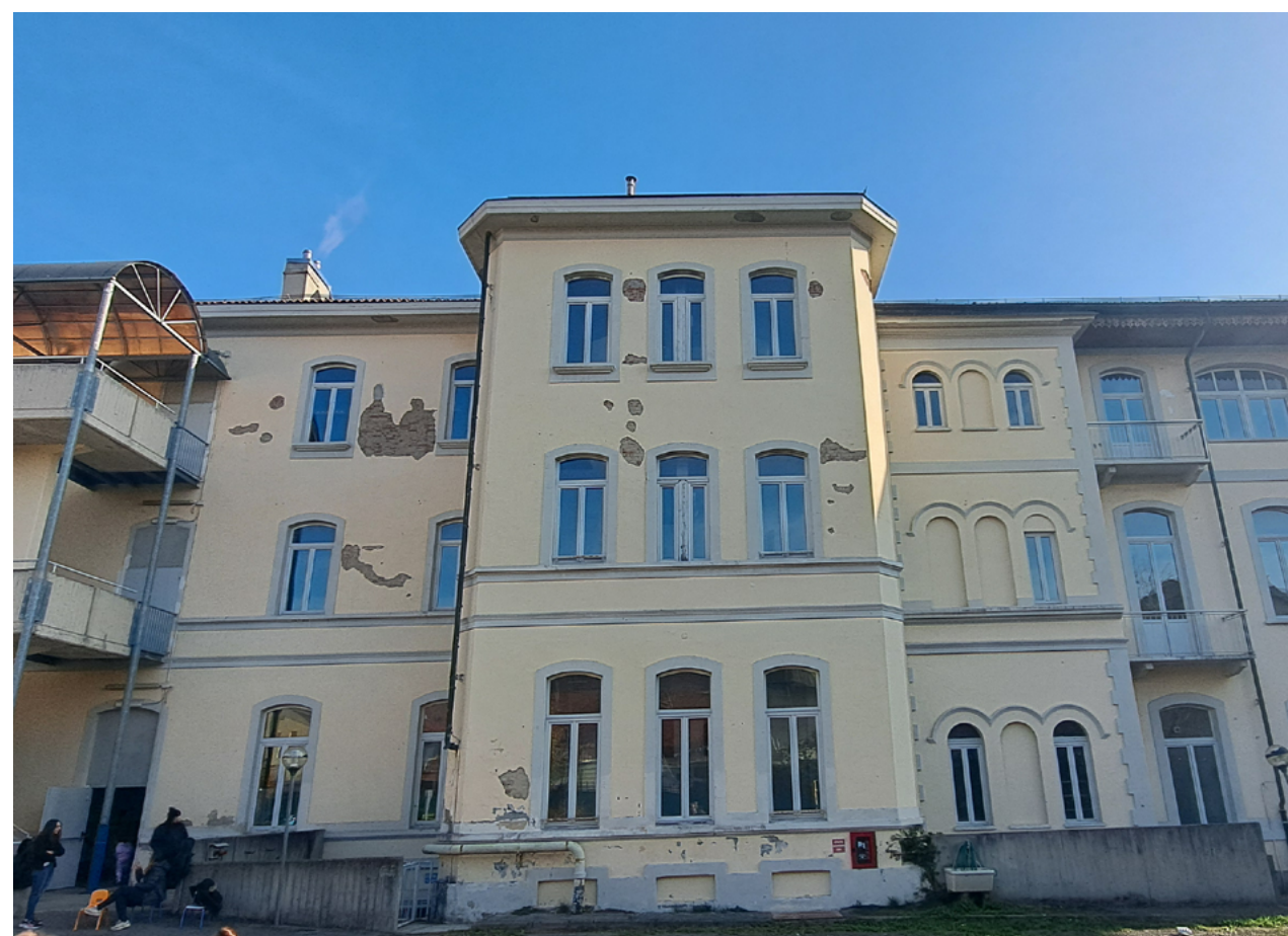
Fig. 8 Dal cortile interno si nota come l'edificio necessiti di ristrutturazione, con parti di intonaco mancanti sulla facciata.
