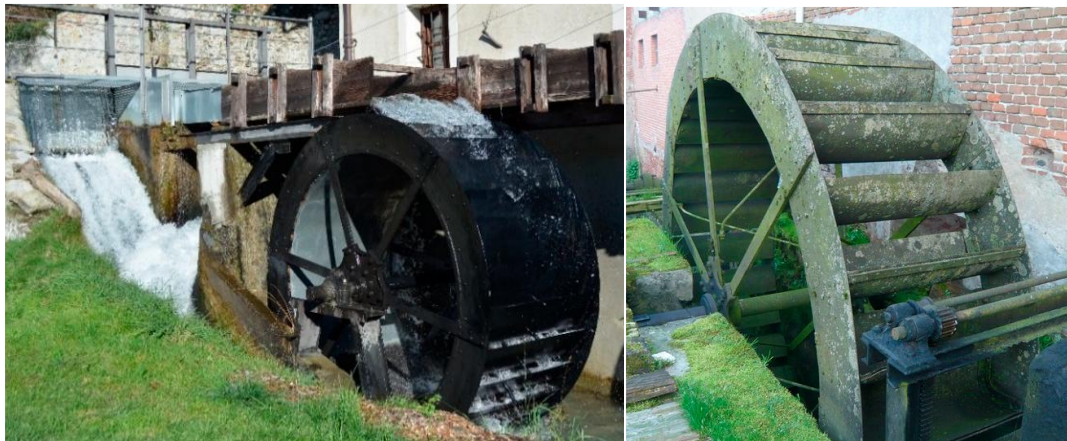
Figura 13: a sinistra la ruota overshoot del mulino Riviera e a destra la ruota breastshot del mulino Forno [5]
