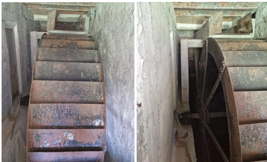
Figura 43: ruota idraulica e canale di alimentazione
