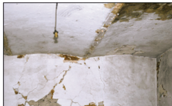
Solaio con travi di ferro a voltine.
