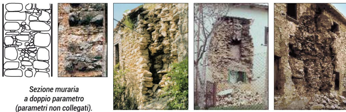
Figura 1.7.3-12: Sezioni paramenti con collegamenti trasversali assenti
