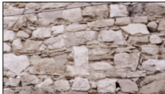
Figura 1.7.3-7: Tabella 1 - Abaco delle murature irregolari (Manuale AeDES)
