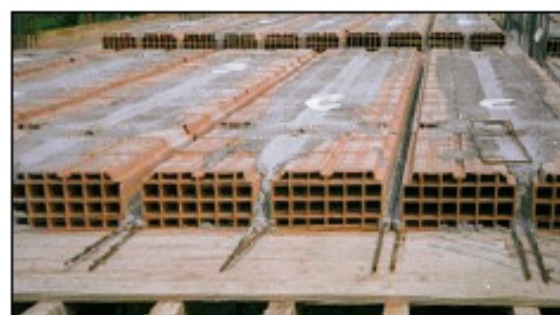
Solaio in laterocemento gettato in opera.
