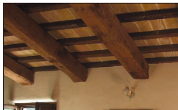
Solaio in legno con mezzana
