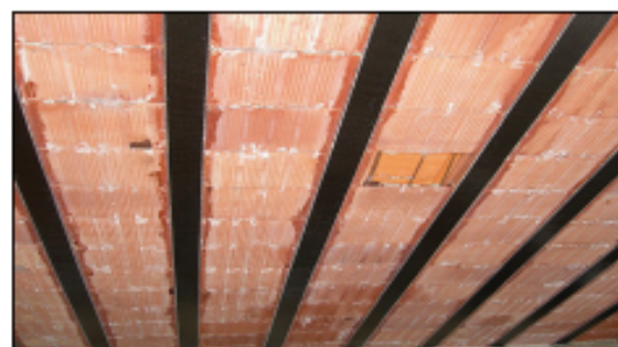
Solaio in ferro e tavelloni.
