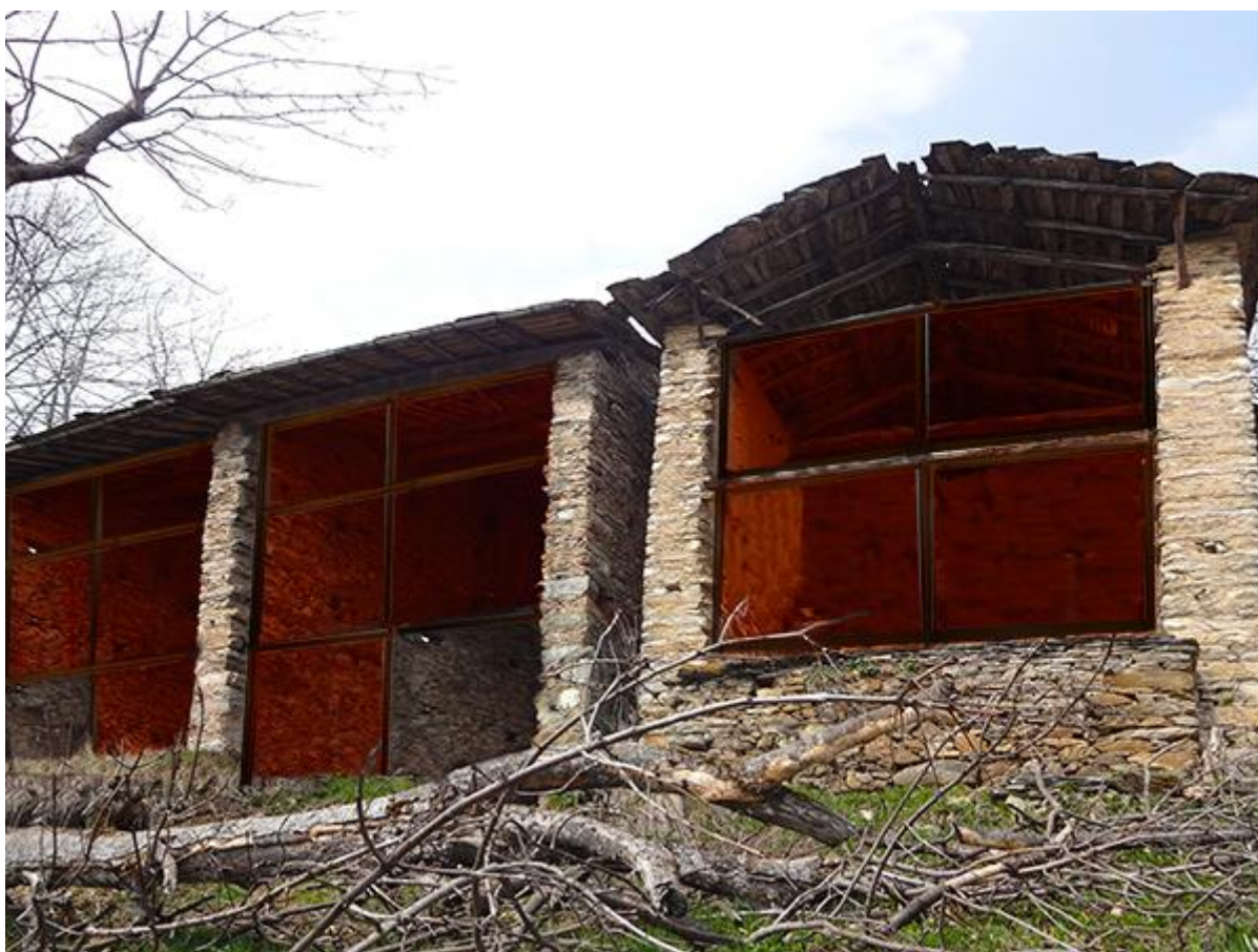
Fotoinserimento con pannelli fotovoltaici
