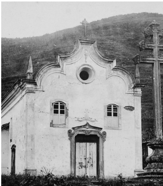
Figure 21 – Capela de Padre Faria, Ouro Preto (Minas Gerais, Brazil). (1) Floor Plan of the Capela de Padre Faria. Published in the article "Morfologia das Igrejas Barrocas II" on May 9, 2012. [Source: Coisas da Arquitetura. Photograph: "Ouro Preto a Capela de Padre Faria com a sua Linda Cruz de Pedra." Anonymous artist, December 1923. Photograph/postcard from the Museu Paulista da USP collection. Source: Wikimedia Commons.]
