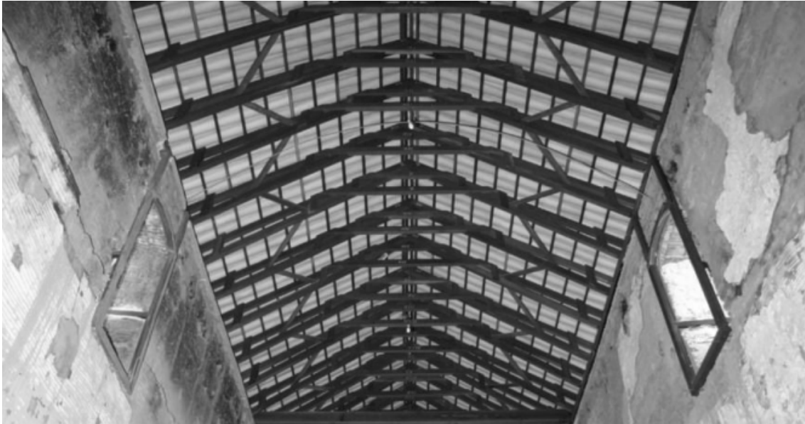
Figure 56 – Restoration of the Roof of the Matriz Church in Pirenópolis in 2002. [Source: CAVALCANTE, Sílvia; CAVALCANTE, Neusa. Barro, madeira e pedra: patrimônios de Pirenópolis. 2nd ed. Brasília:IPHAN, 2019.]
