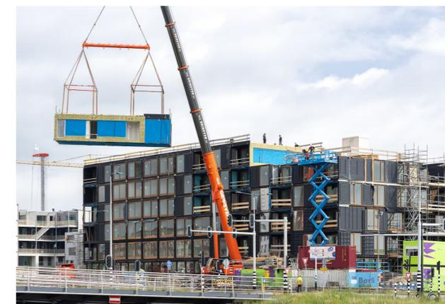
L'utilizzo di autogrù e un numero limitato di operatori per il posizionamento dei moduli prefabbricati.
