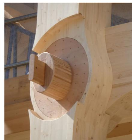
Connessione ad incastro realizzata grazie alla precisione con macchinari CNC
