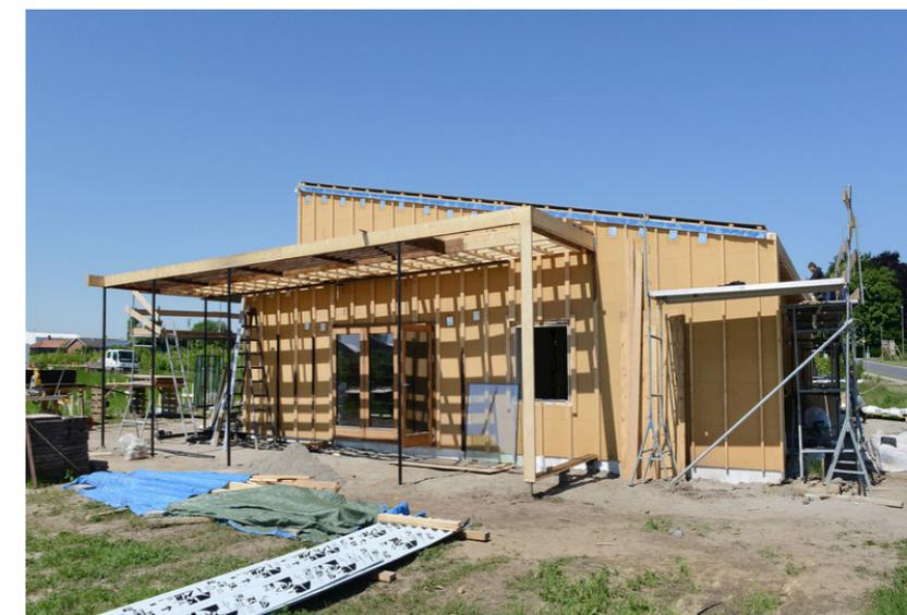
I container riutilizzati sono stati rivestiti da una struttura che incrementa gli spazi interni.
