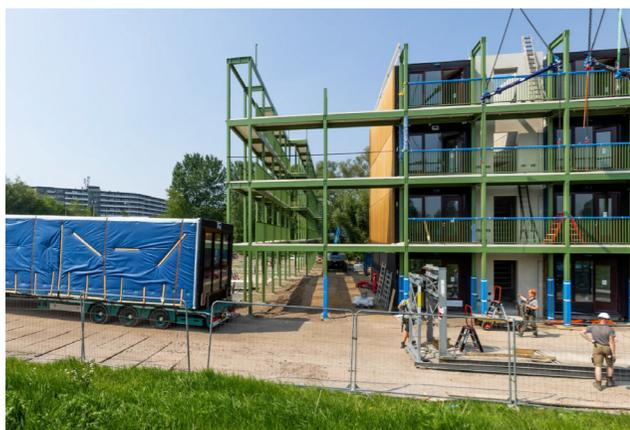
Trasporto dei moduli in cantiere tramite bilico ribassato.
