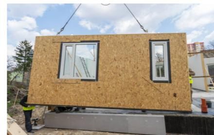
Elemento bidimensionale prefabbricato telaio in legno.
