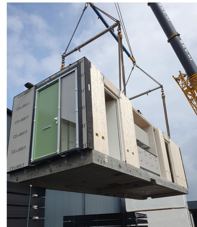
Assemblaggio dei moduli prefabbricati per la costruzione di MOOS Euterpe
