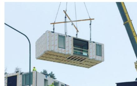
Elemento tridimensionale prefabbricato realizzato per il progetto Puukuokka housing block, OOEPEA.
