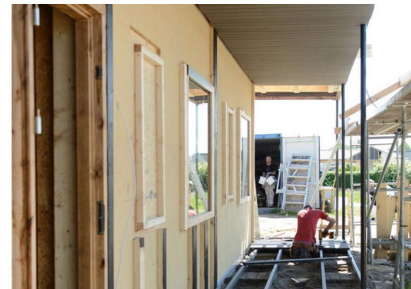
Le componenti utilizzate provengono da processi circolari e sono state assemblate a secco
