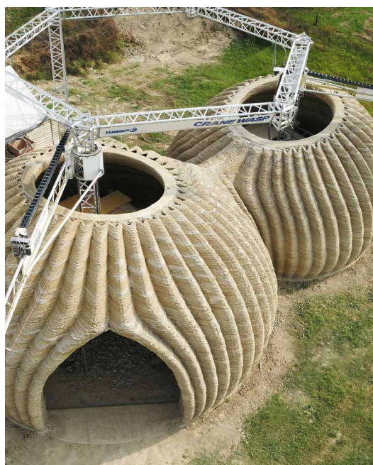
Fig.140 Immagine di cantiere. https://www.3dwasp.com/casa-stampata-in-3d-tecla/
