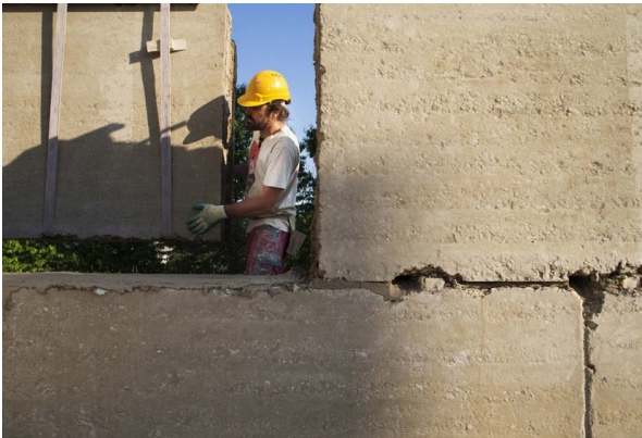
Fig. 106 Installazioni delle pareti in terra battuta. https://www.lehmtonerde.at/en/projects/project.php?plD=87
