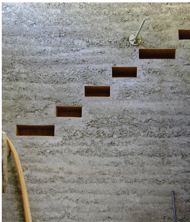
Fig. 64 Immagine di cantiere in cui mostra i corpo di cassero predisposto nella parete in terra cruda per l'alloggiamento delle pedate Fonte: https://www.bauhandwerk.de/artikel/bhw_Kontrollierte_Erosion_im_Lehmbau-1176521.html
