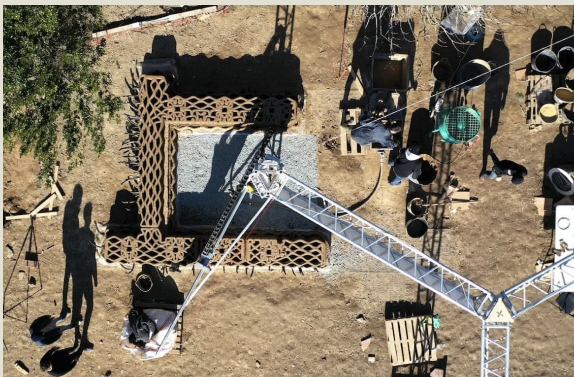
Fig. 34 Stampa in corso di un modulo abitativo on site https://www.rinnovabili.it/green-building/materiali-e-tecnologie/lundp-stampera-case-in-3d-in-colombia-grazie-alla-tecnologia-italiana-wasp/
