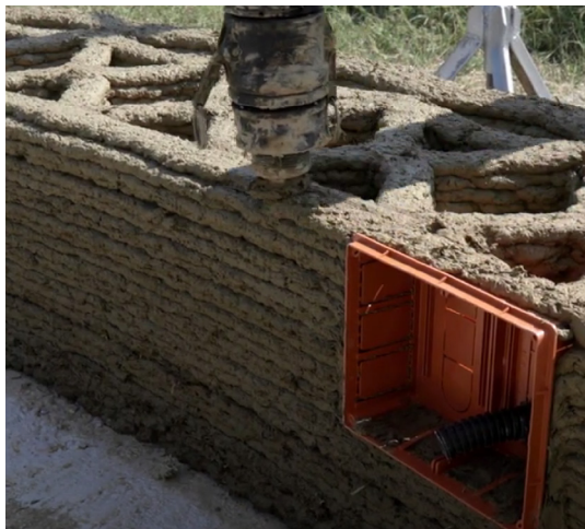
Fig.128 Stampa del muro con l'integrazione di spazi appositi per gli impianti. https://www.youtube.com/watch?v=aUALAn_1hNw&list=PLKSfMq7r3YolyGxCU8xhfNLVcLH5KMhxT&index=2
