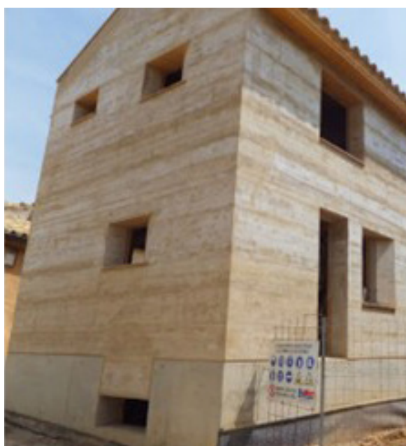
Fig. 80. Immagine del cantiere in corso. Fonte: https://arquitecturayempresa.es/noticia/por-que-no-una-vivienda-de-tapia-en-el-siglo-xxi
