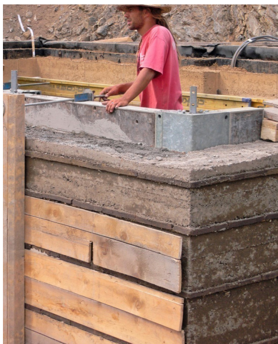
Fig. 54. Cassaforma in legno e acciaio
