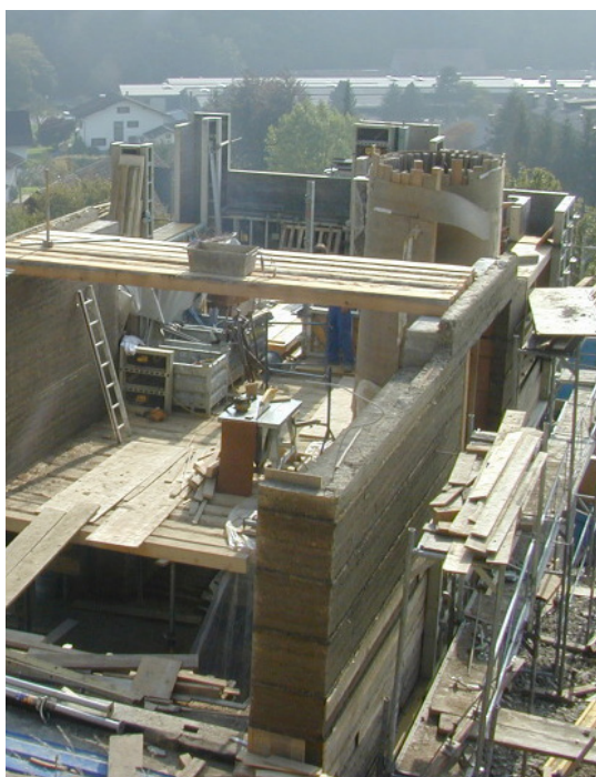
Fig. 55. Immagine dell'avanzamento del cantiere
