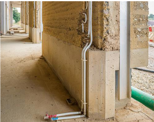
Fig. 117 Blocchi prefabbricati (pareti Erden) con sistema di riscaldamento integrato Fonte: https://www.ubm-development.com/magazin/en/a-love-of-loam/
