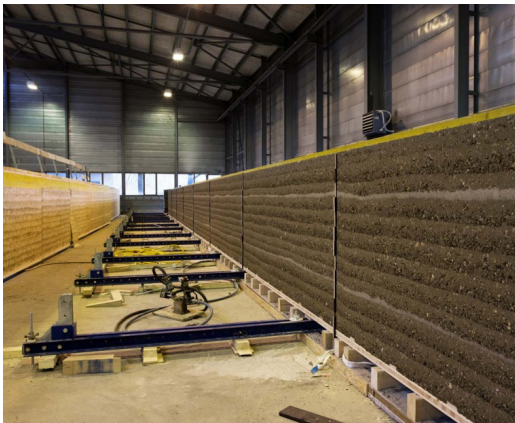
Fig. 102 produzione di pannelli con Roberta https://www.lehmtonerde.at/en/projects/project.php?plD=87
