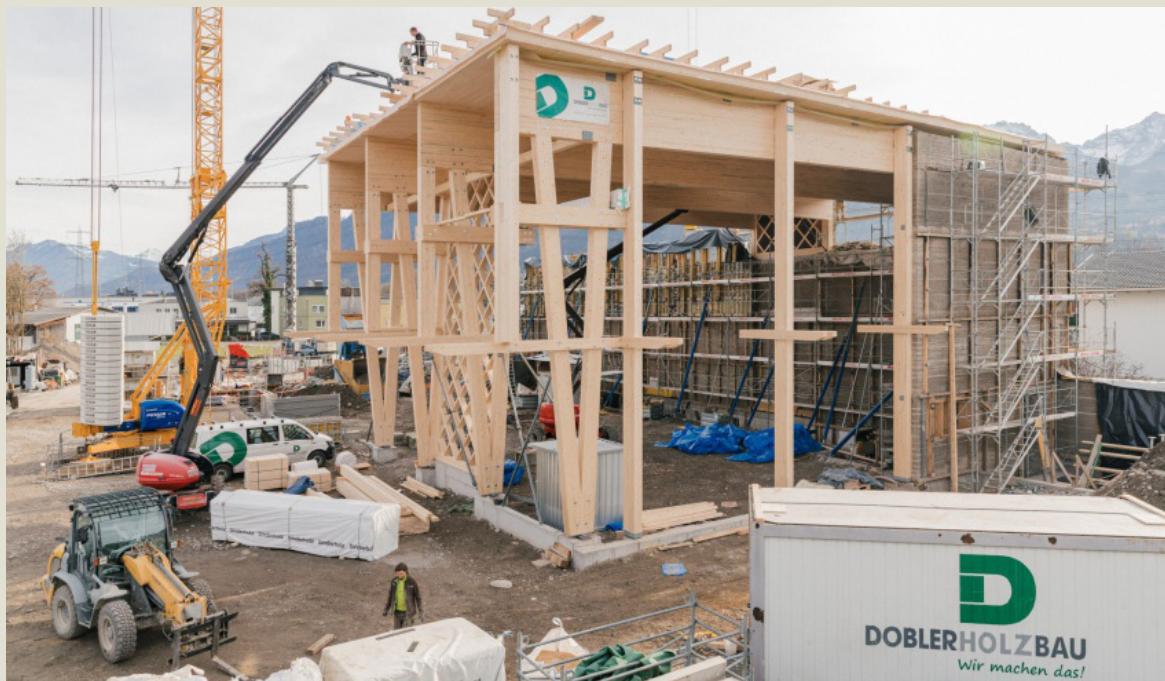
Fig. 23 Vista della struttura portante in legno lamellare in fase di montaggio, con intelaiatura a telaio, controventi diagonali e prime fasi della posa delle pareti in terra cruda (pisé), a evidenziare l'integrazione tra materiali naturali e tecniche prefabbricate.
