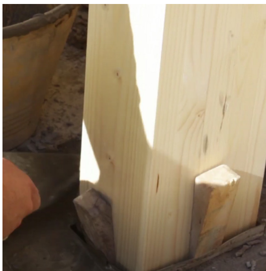
Fig.130 Incastro dei pilastri nella soletta in cemento. https://www.youtube.com/watch?v=3gYc1F1FoGM&list=PLKSfMq7r3YolyGxCU8xhfNLVcLH5KMhxT&index=11
