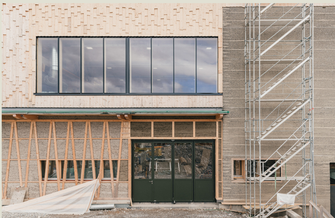
Fig. 24 Particolare del fronte principale in fase di completamento. L'involucro combina tre materiali principali: terra cruda a strati compattati (pisé), struttura lignea a vista e rivestimento in scandole di legno nella parte superiore. Fotografia di Hanno Mackowitz, Fonte: https://www.erden.at/ERDEN-Werkhalle
