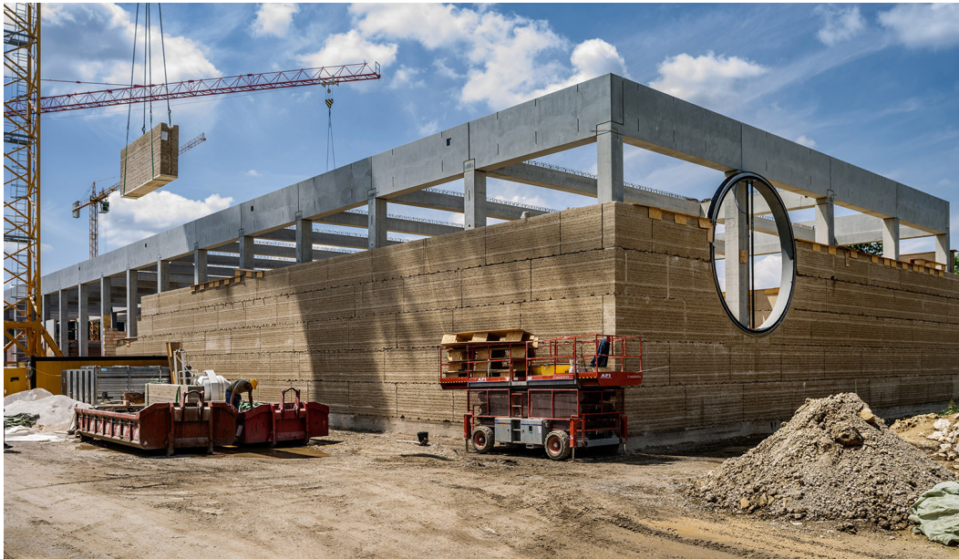
Fig. 107 Immagine di cantiere.
