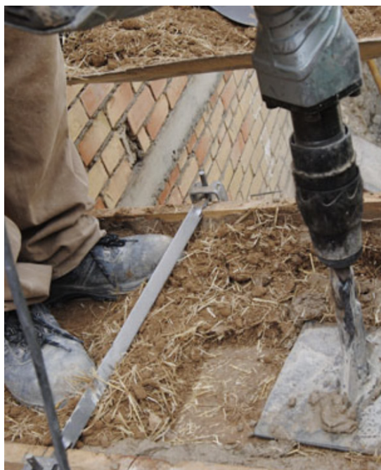
Fig 77. Compattazione della terra nel cassero mediante martello pneumatico. Fonte: https://amaco.org/une-maison-vernaculaire-contemporaine-angels-castellarnau-visus/
