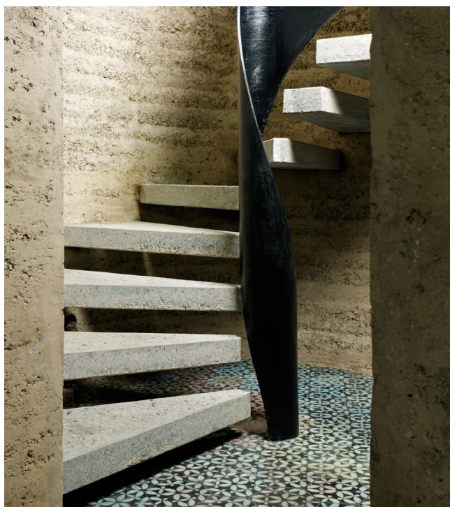
Fig. 65 Immagine del corpo scala, Fotografia di: Albrecht Schnabel Fonte: https://boltshauser.info/projekt/haus-rauch/
