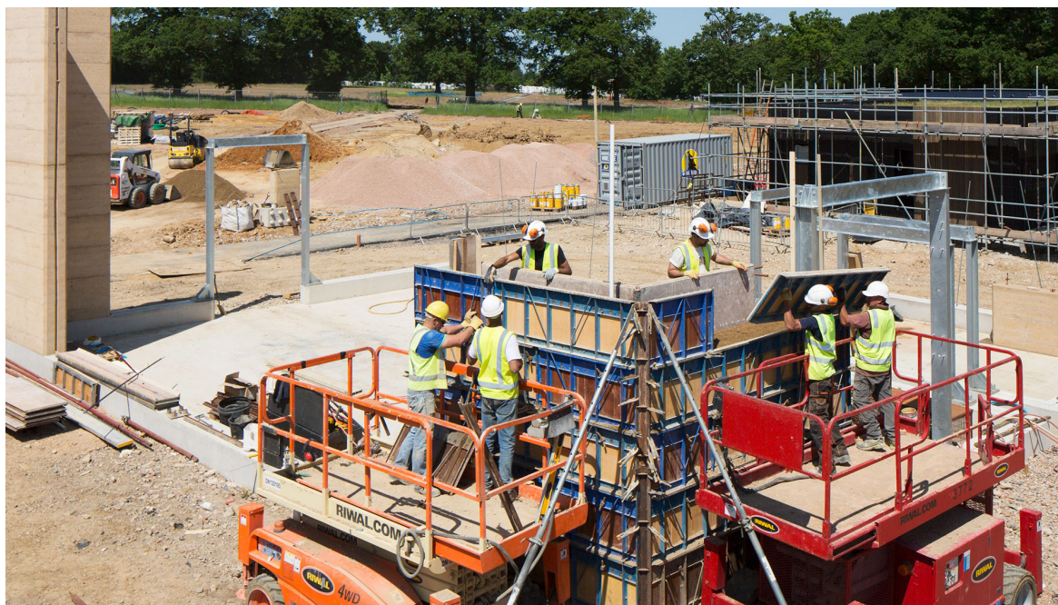
Fig. 90 Immagini del cantiere in opera.
