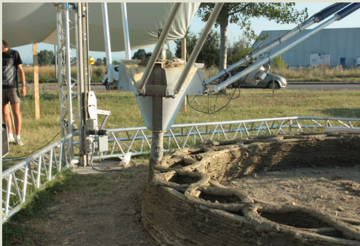
Fig 36 Prova di costruzione in terra cruda con Big Delta 12 mt https://www.3dwasp.com/stampiamo-insieme-la-prima-casa-di-terra/
