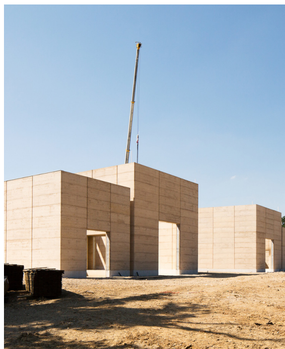
Fig. 92 Immagine del cantiere in opera. Fotografia di Lewis Khan. Fonte: https://www.archdaily.com/901249/bushey-cemetery-waugh-thistleton-architects .
