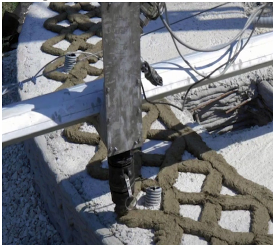
Fig.127 Stampa del primo layer sulla soletta di calcestruzzo. https://www.youtube.com/watch?v=eEuObYmqalk&list=PLKSfMq7r3YolyGxCU8xhfNLVcLH5KMhxT&index=1
