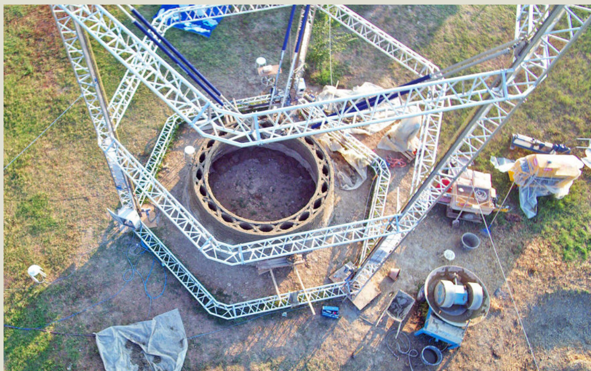
Fig 37. Prova di costruzione in terra cruda con Big Delta 12 mt https://www.3dwasp.com/stampiamo-insieme-la-prima-casa-di-terra/
