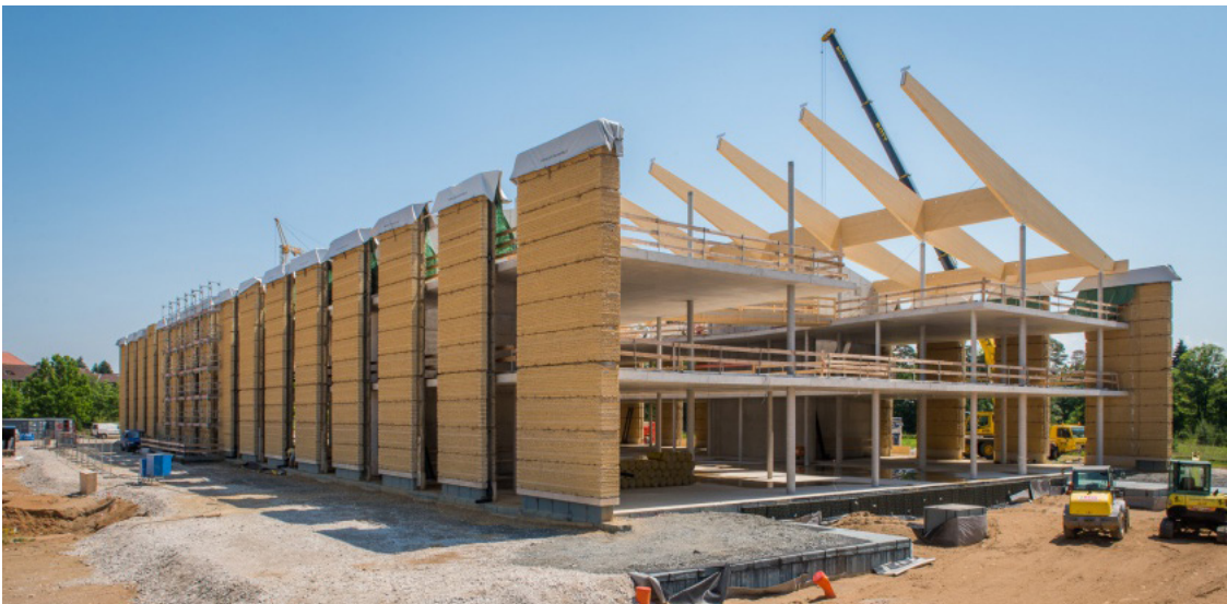
Fig. 120 Immagine di cantiere in corso. Fonte: https://www.lehmtonerde.at/en/projects/project.php?plD=97
