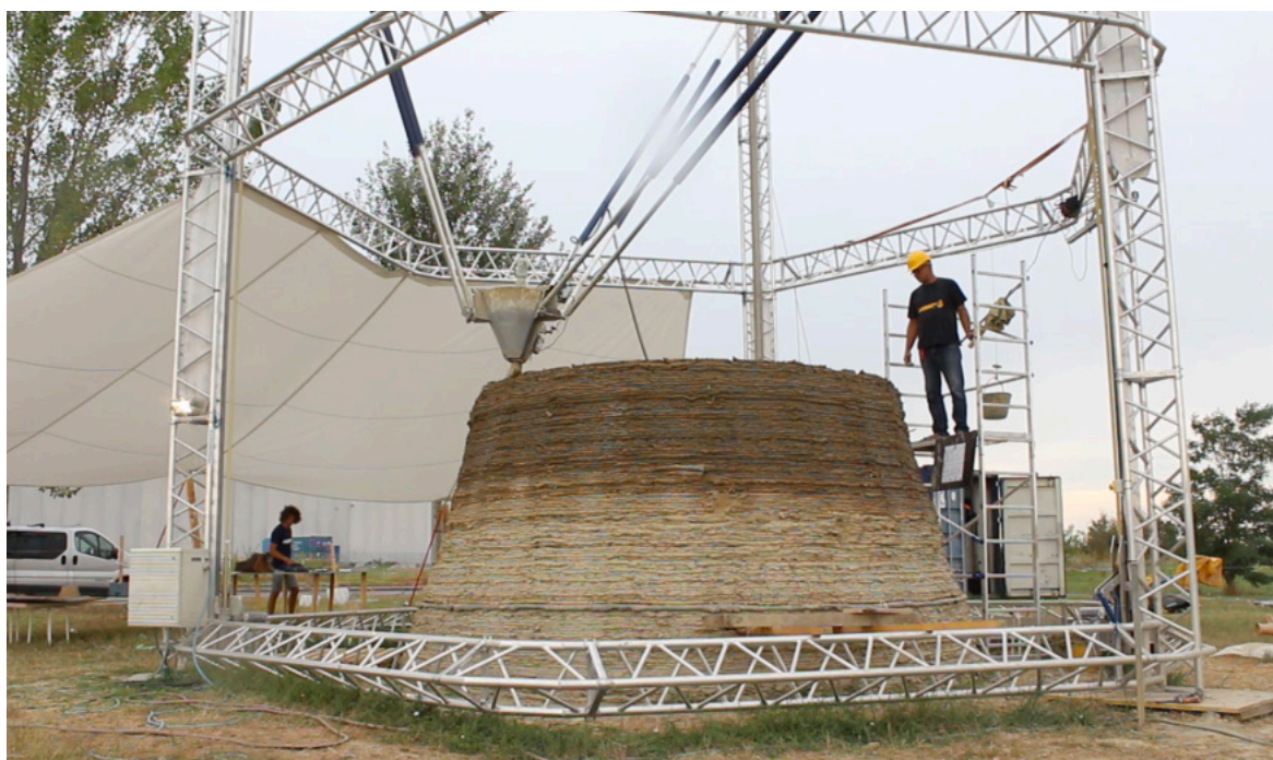
Fig. 20 Stampa in corso con Big delta 12mt. Fonte: https://www.3dwasp.com/il-muro-di-terra-e-paglia-alle-soglie-dei-3-metri/
