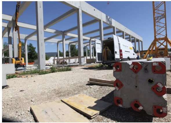
Fig. 105 Assemblaggio del sistema portante prefabbricato in calcetsruzzo. https://www.peikko.it/reference/ricola-herb-center/
