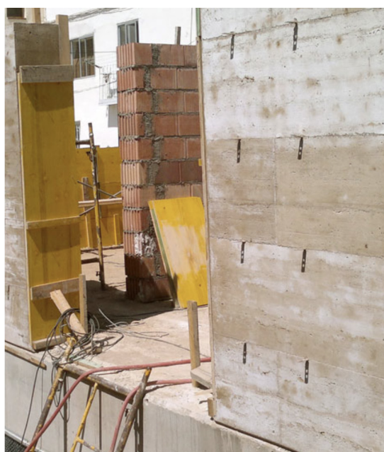
Fig. 79 Immagine dei blocchi in terra battuta realizzati in cantiere per la costruzione delle pareti. Fonte: https://amaco.org/une-maison-vernaculaire-contemporaine-angels-castellarnau-visus/
