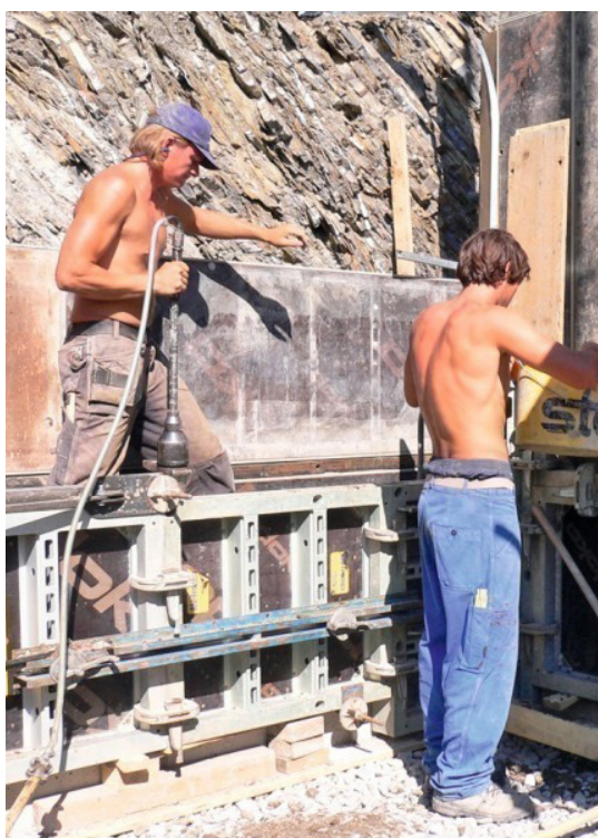
Fig. 53. Compressione della terra battuta
