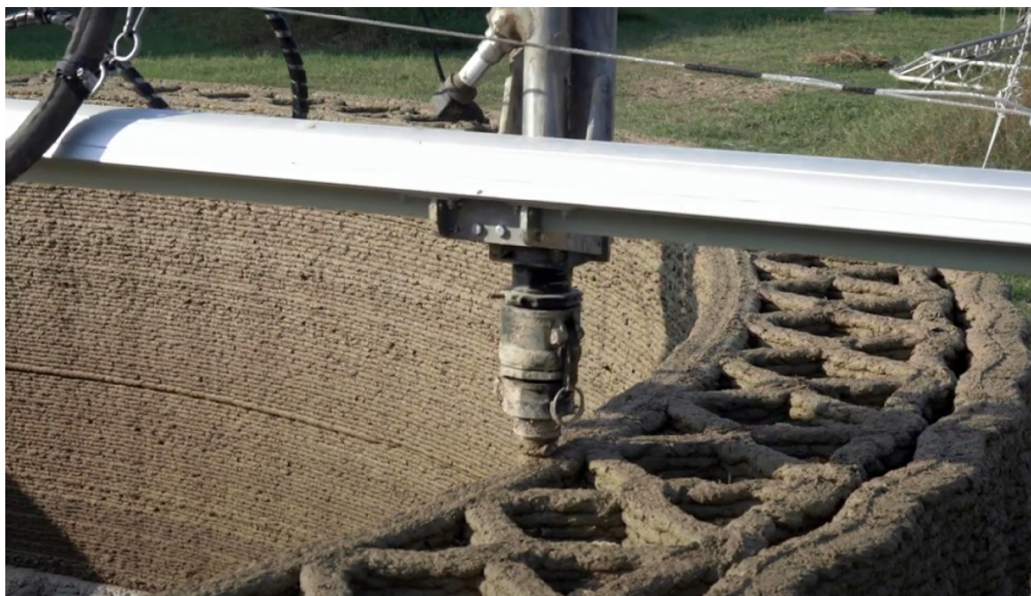
Fig. 21 Stampa 3D in corso con argilla: l'estrusore deposita strati di materiale per creare strutture architettoniche sostenibili. Fonte: https://www.youtube.com/watch?v=pf2PTyoRG4E&list=PLKSfMq7r3YolyGxCU8xhfNLVcLH5KMhxT&index=3
