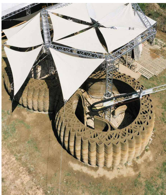
Fig.139 Immagine di cantiere. https://www.3dwasp.com/casa-stampata-in-3d-tecla/
