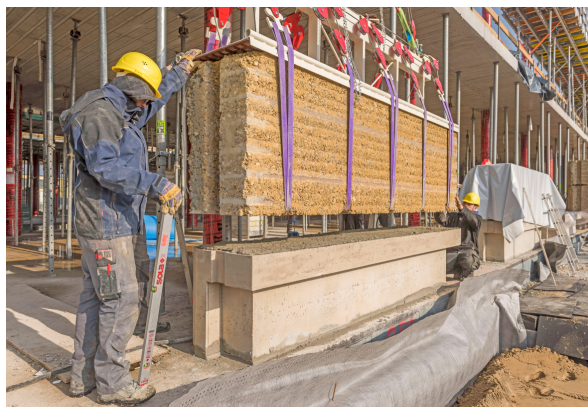
Fig. 119 Montaggio dei blocchi prefabbricati Fonte: https://www.bauhandwerk.de/artikel/bhw_Groesste_Lehmfassade_Europas-3321098.html
