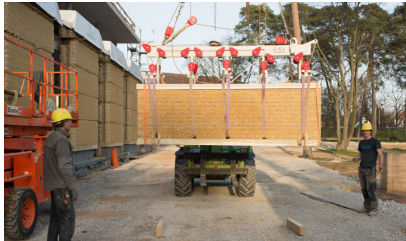
Fig. 118 Fotografia in cui vengono trasportati blocchi per il montaggio in cantiere. Fonte: https://www.lehmtonerde.at/en/projects/project.php?plD=97
