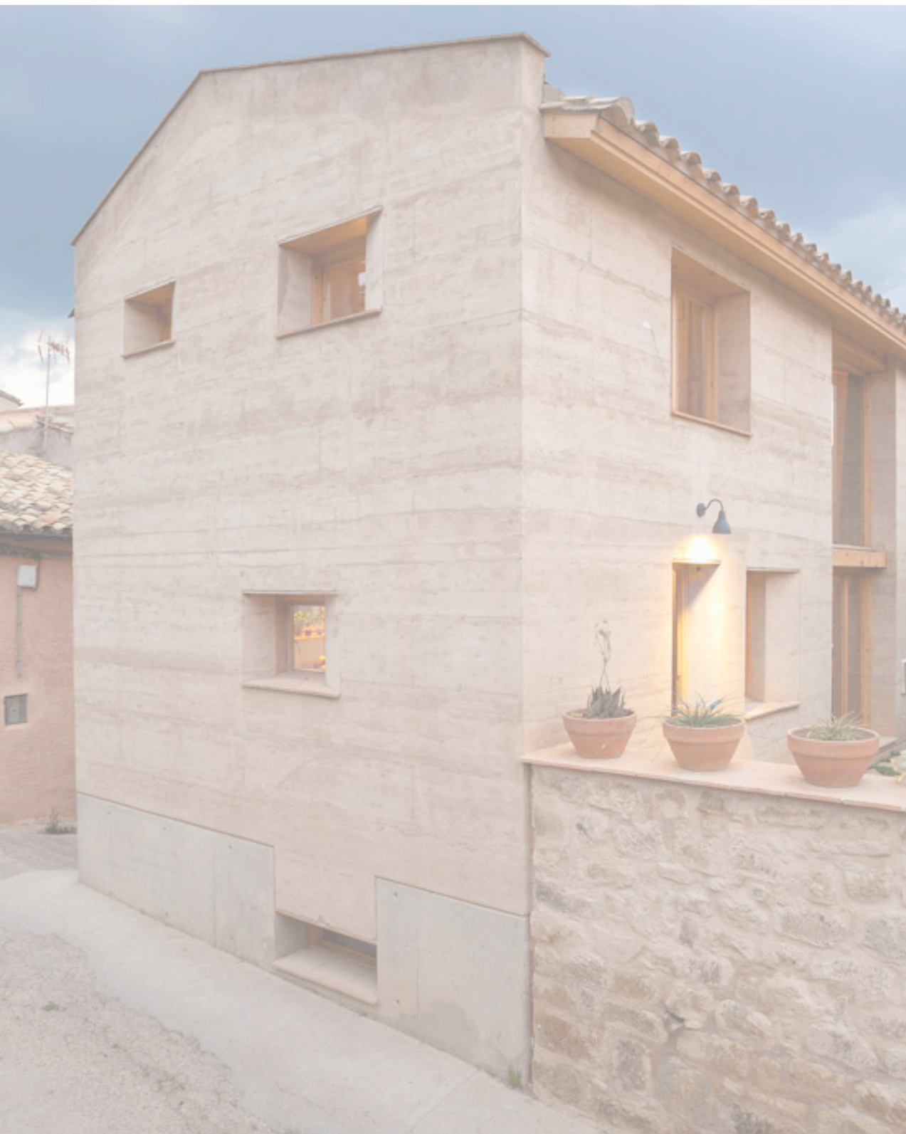
Fig. 71 Facciata Casa de Tapia su lato strada. Fotografia di Xavier d'Arquer tratta da: https://arquitectura.edraculturaynaturara.com/portfolio-item/casa-de-tapia-en-ayerbe/
