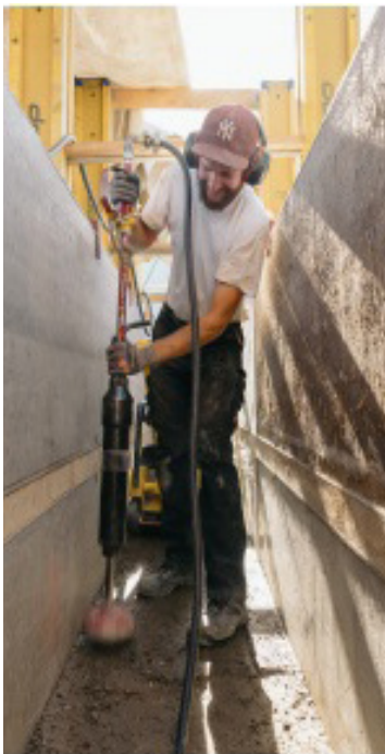
Fig. 12 Costruzione di un muro in terra battuta con compattore pneumatico https://www.architectural-review.com/buildings/earth/retrospective-martin-rauch
