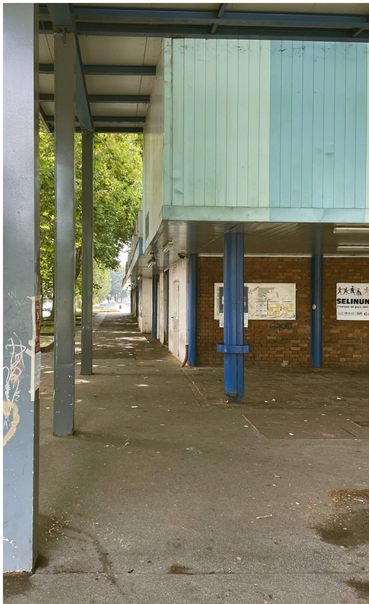
Quartiere San Siro, struttura ex-mercato. Foto degli autori.
