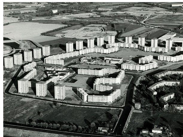
Fig.1.7: Falchera Vecchia in costruzione intorno al 1954; edifici della Falchera Nuova a fine anni Settanta. Fonte: Museo Torino/Archivio Storico della Città di Torino (fotografia R. Moncalvo).
