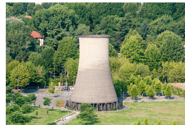
Fig.2.4:La torre evaporativa dell'ex stabilimento Michelin oggi integrata nel Parco Dora. Fonte: Wikimedia Commons - Panoramio, autore Uccio "Uccio2" D'Ago.
