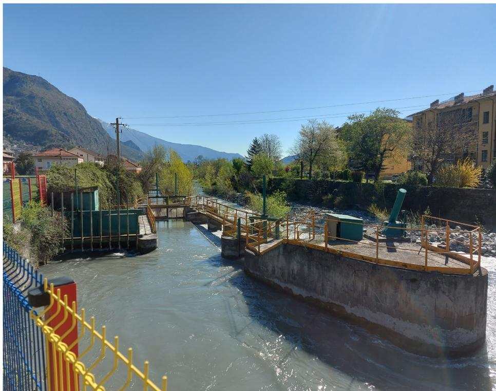
Fig.4.B.11 - Sistema di canalizzazione del fiume verso la centrale idroelettrica.
