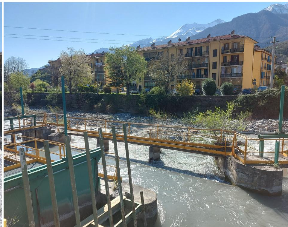
Fig.4.B.12 - Sistema di canalizzazione del fiume verso la centrale idroelettrica.
