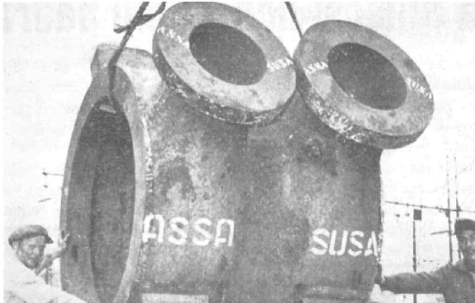
Fig.2.11 - Cassa compressore in acciaio legato (1968).
