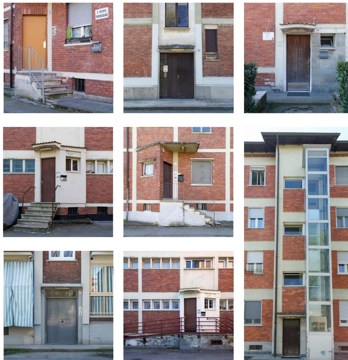
**Immagine n.90.** Queste immagini evidenziano le criticità nell'accessibilità alla scala architettonica. Nell'ultima foto vediamo una soluzione adottata con l'inserimento di un ascensore al mezzo piano.
