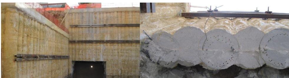
**Figura 2.6:** Muro di sostegno realizzato in CSP [4]
