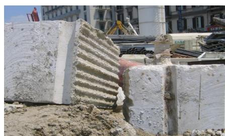
Figura 2.28: Superficie di giunzione in calcestruzzo [6]
