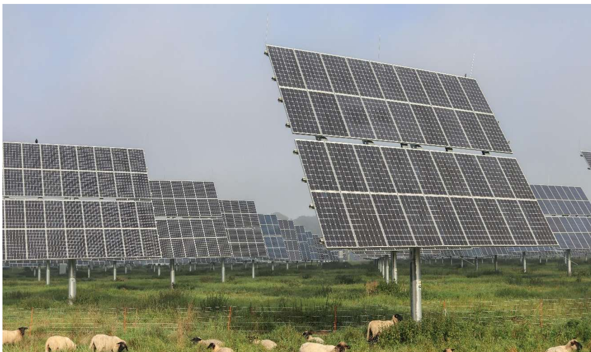
[Figura 28] Sistema fotovoltaico ad inseguimento attivo
