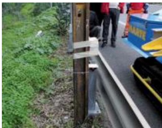
Figura 29: Esempio di prova per la determinazione della resistenza del terreno (IN SITO)
