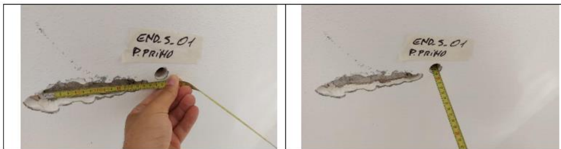
Documentazione fotografica solaio – Larghezza travetto 12 cm + h totale solaio senza piastrella
