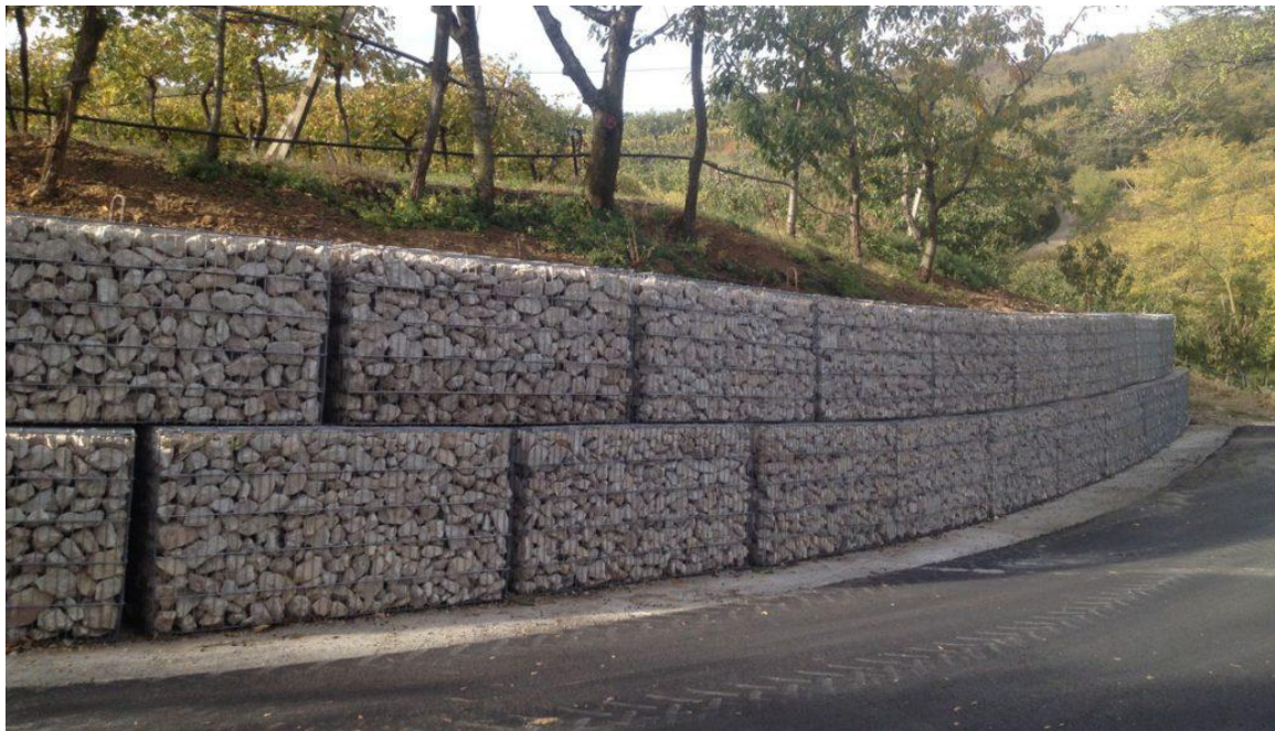
Figura 6.11 Esempio di gabbionature di contenimento (Fonte: www.cordioli.biz )
