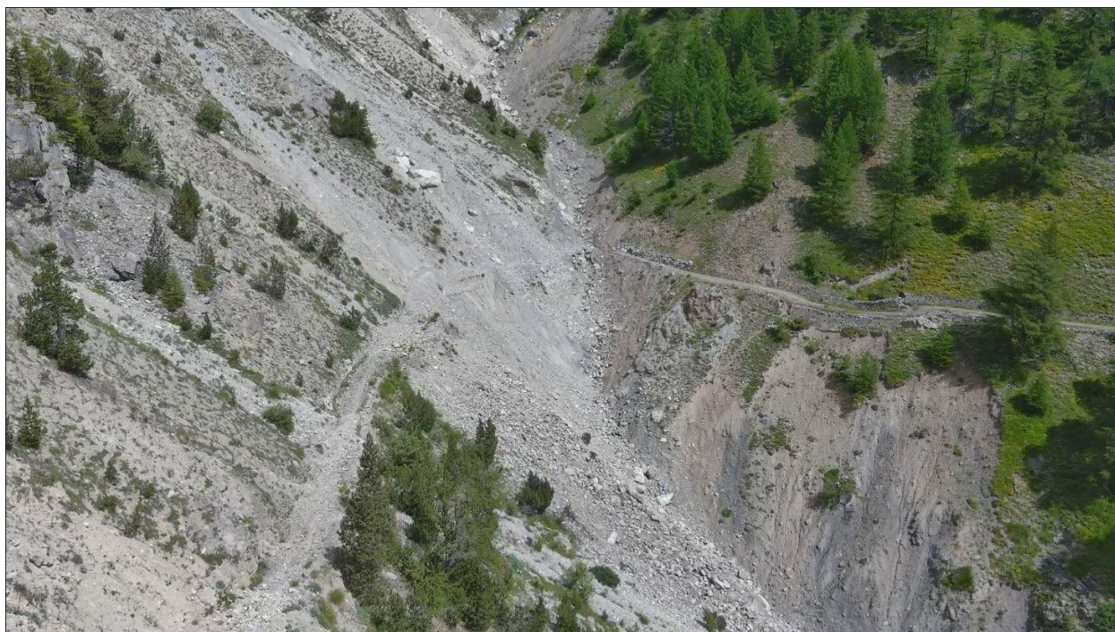
Figura 6.1 Ex strada militare di Fenils interrotta da debris flow lungo il Rio Inferno (vista frontale). (Foto scattata da drone CFVAS – 13/07/23)
