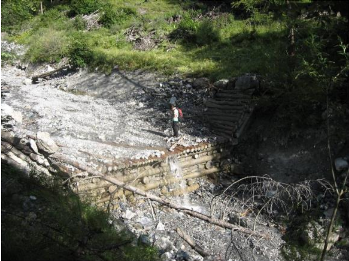
Figura 4.4 Briglia in buone condizioni lungo il Rio Fenils, dopo l'evento del 2013.
