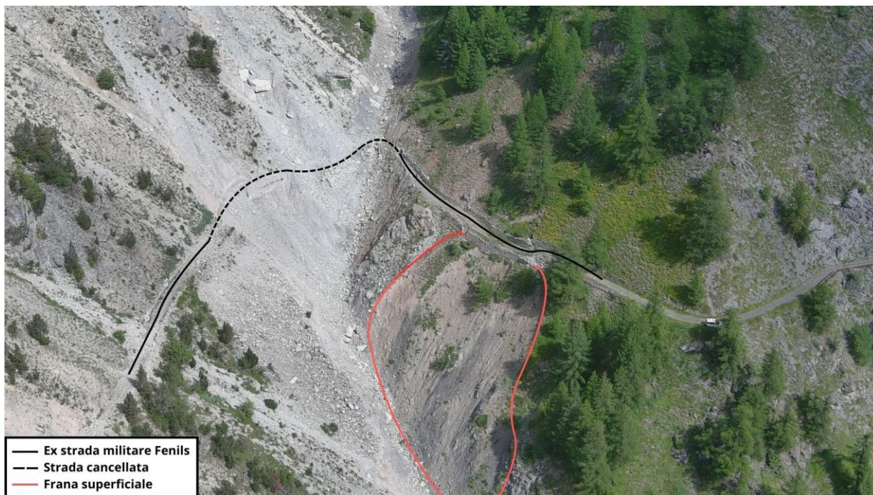
Figura 4.15 Vista frontale del debris flow sul Rio Inferno che attraversa la strada. (Foto del 13/07/2023 scattata dal drone CFVAS – per gentile concessione di Federico Morra di Cella – presidente CFVAS)
