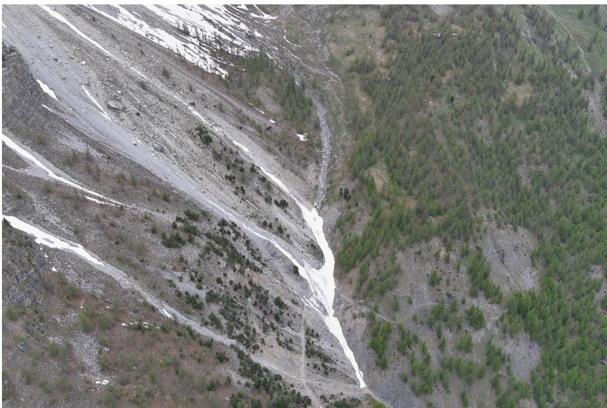
Figura 4.18 Vista aerea del sottobacino del Rio Inferno. (Foto del 30/05/2024 scattata dal drone CFVAS – per gentile concessione di Federico Morra di Cella – presidente CFVAS)
