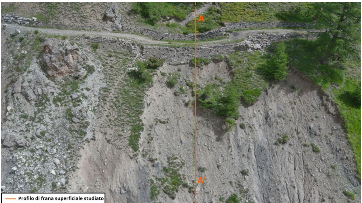
Figura 6.4 Frane superficiali sottostanti la ex strada militare di Fenils ricadenti sul Rio Inferno. Nella parte superiore della foto la tension crack. (Foto scattata da drone CFVAS)
