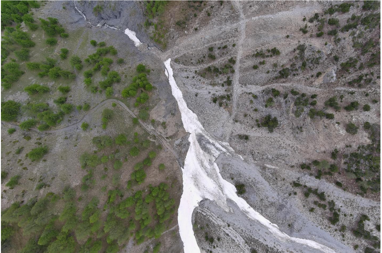
Figura 4.19 Vista dall'alto dell'area critica. (Foto del 30/05/2024 scattata dal drone CFVAS – per gentile concessione di Federico Morra di Cella – presidente CFVAS)
