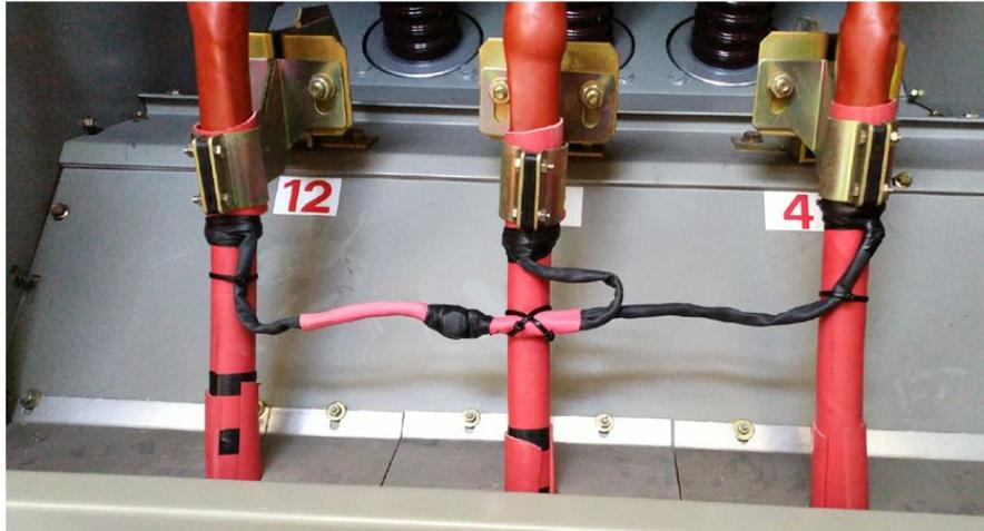
**Figura 7.1:** Collegamento Single point bonding degli schermi dei cavi MT
