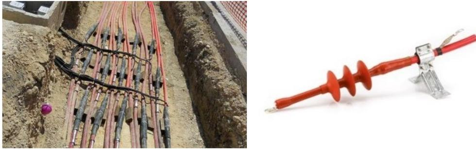
**Figura 2.2:** Buca giunti e terminale unipolare per cavo MT [18]
