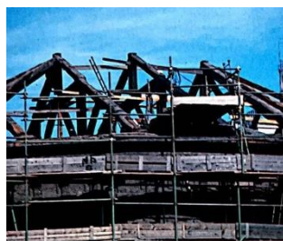
Figure 18. The framework of the pavilion's roof. Imagine from la rimozione del manto lascia vedere lorditura portante del tetto del padiglione.
