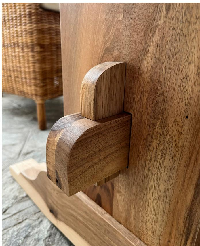
Fig. 105: dettaglio cuneo
