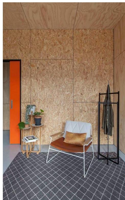
Fig. 25: interno con pannelli OSB
