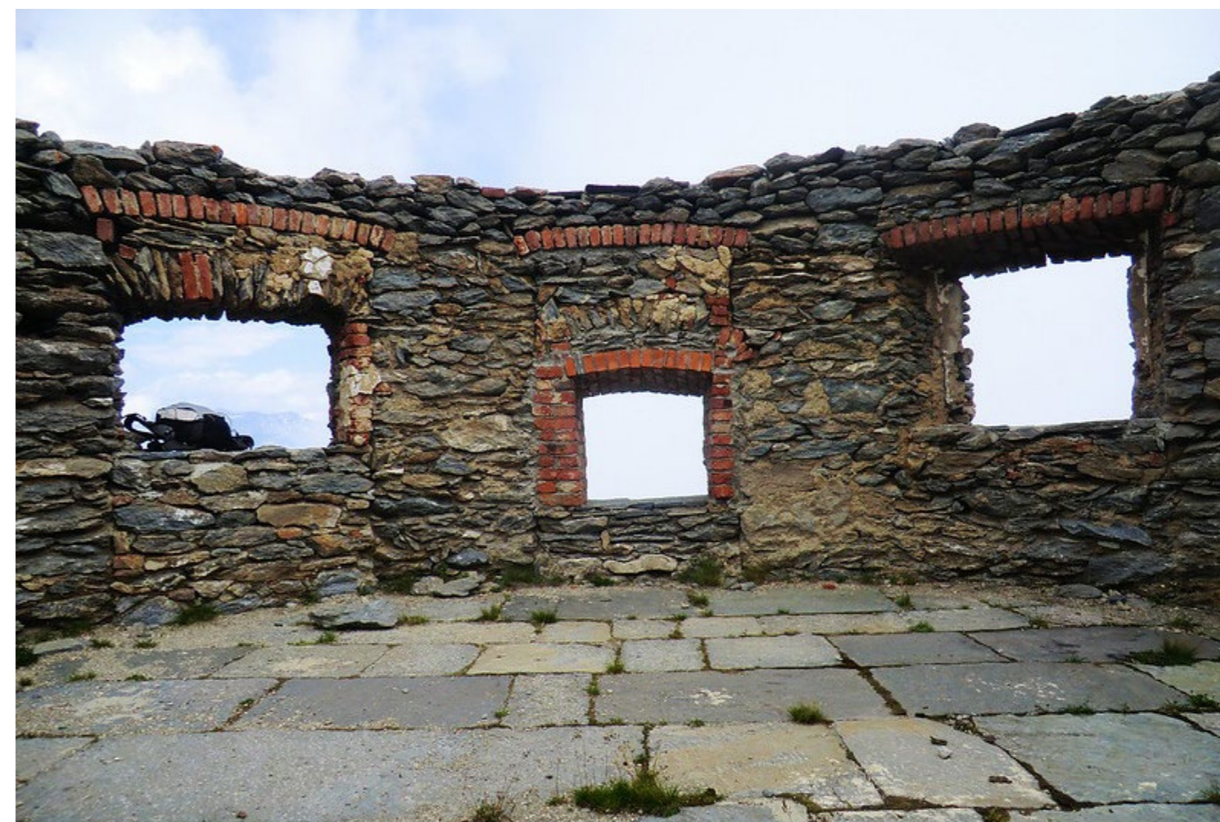
Interno stazione ottica di Punta del Mezzodi nel locale in cui era posizionato l'eliografo, Fonte: foto dell'autore
