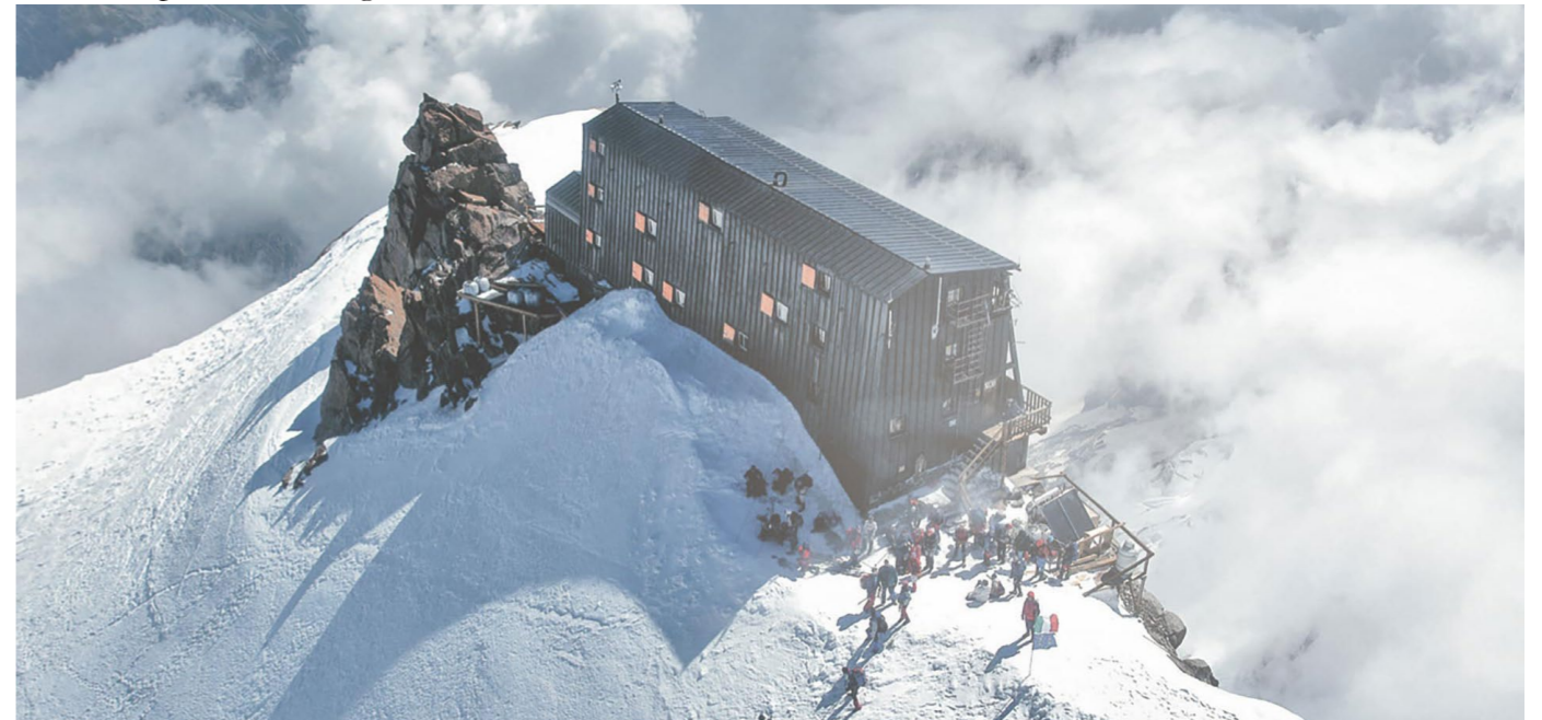
Prospetto nord-ovest della Capanna Regina Margherita. Fonte: olivari.it
