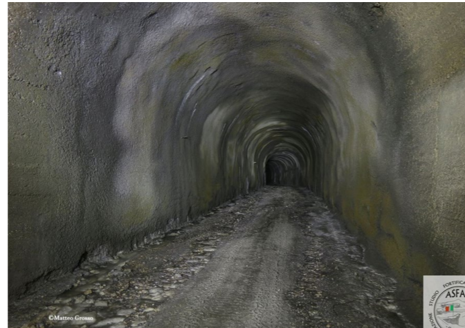
L'interno della galleria, Fonte: Associazione Studio Fortificazioni Alpine Occidentali
