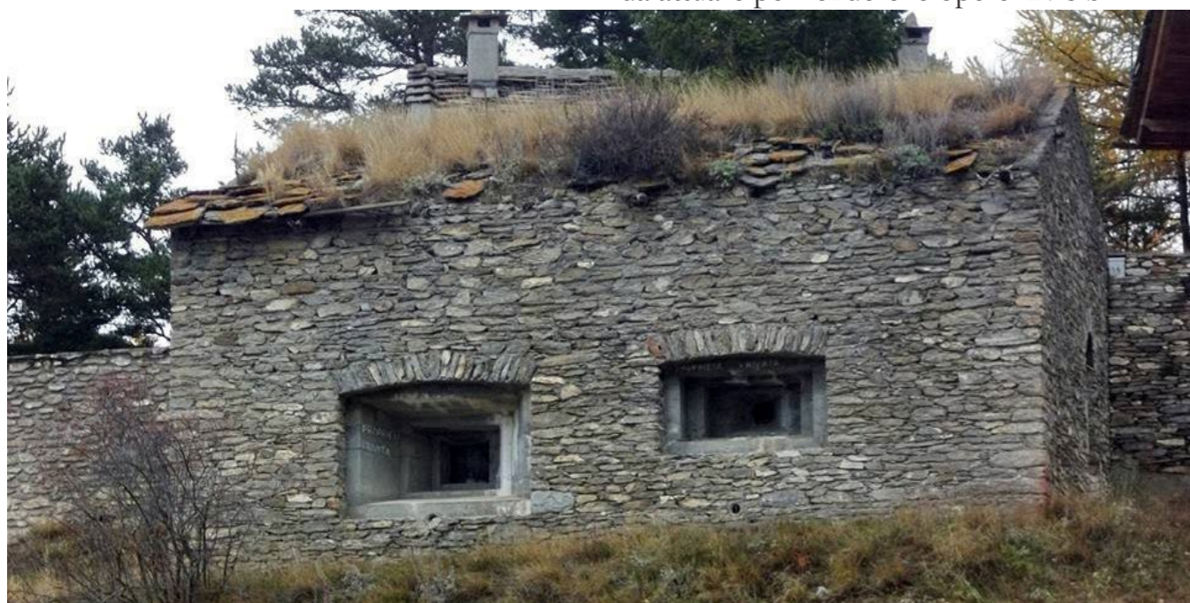
Sbarramento Monfol(Oulx)postazione 205. Fonte: Archivio 1°Reparto Infrastrutture di Torino - Esercito italiano
