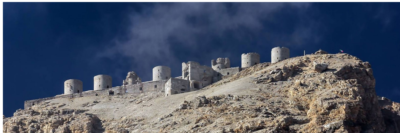
Stazione d'arrivo teleferica dello Chaberton. Fonte: montachaberton.it
