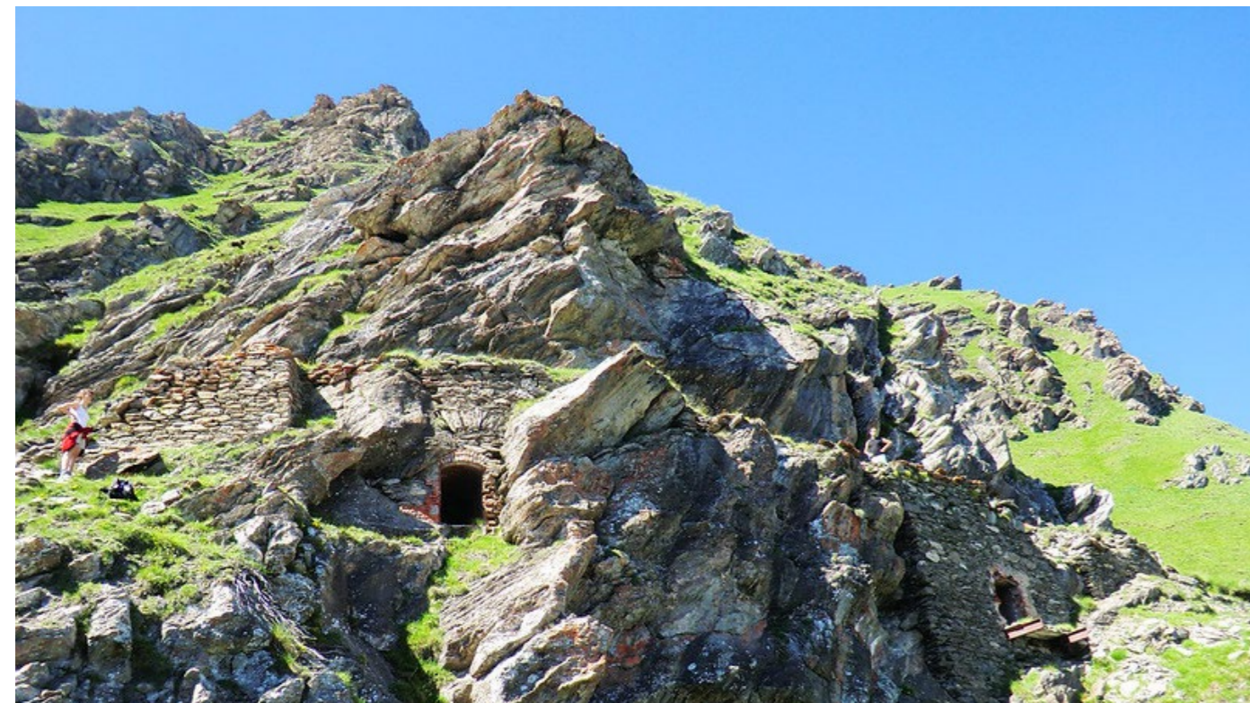
Camere da mina lungo il percorso della strada militare Colle Finestre - Gran Serin, Fonte: foto dell'autore
