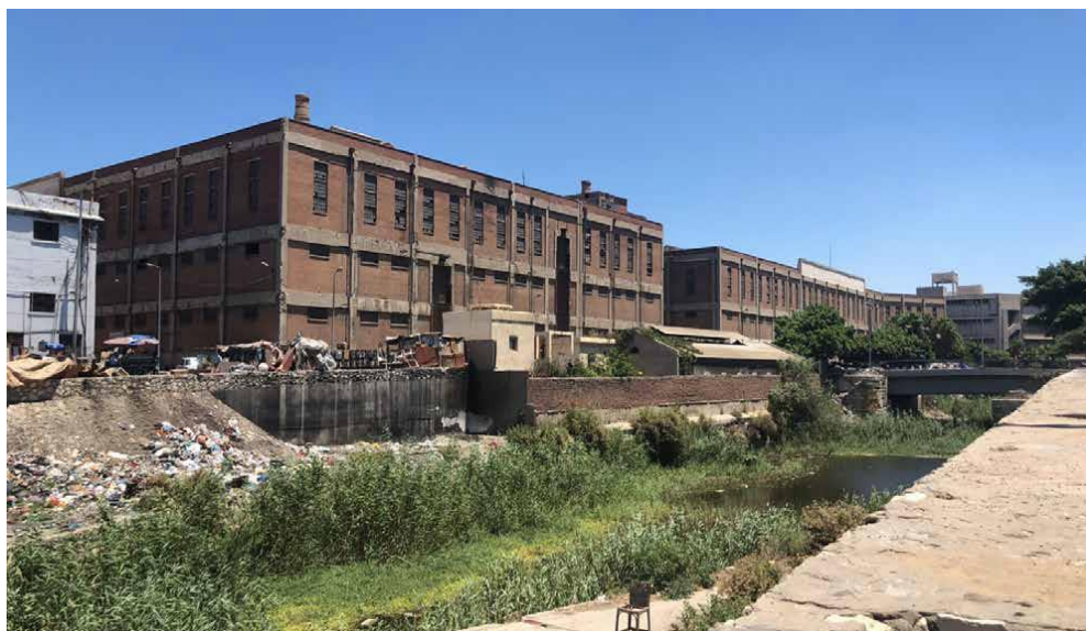
Fig.5.13. The pair of the currently operating Société Général de Pressage et de Dépôts cotton presses, (2019). (Author & ANPIEMED)
