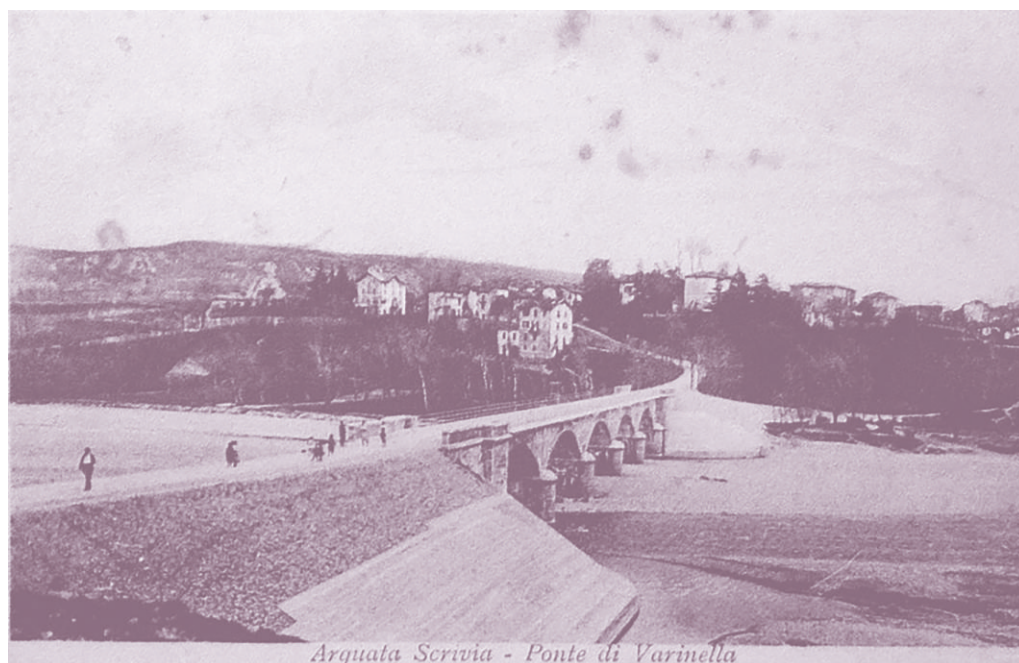
Fig. 43. A brick bridge to Varinella designed by Arnaldo Gardella from 1912-1914. Source: Chieketè – Associazione Storico Culturale Serra vallese e dell'Oltregiogo.
